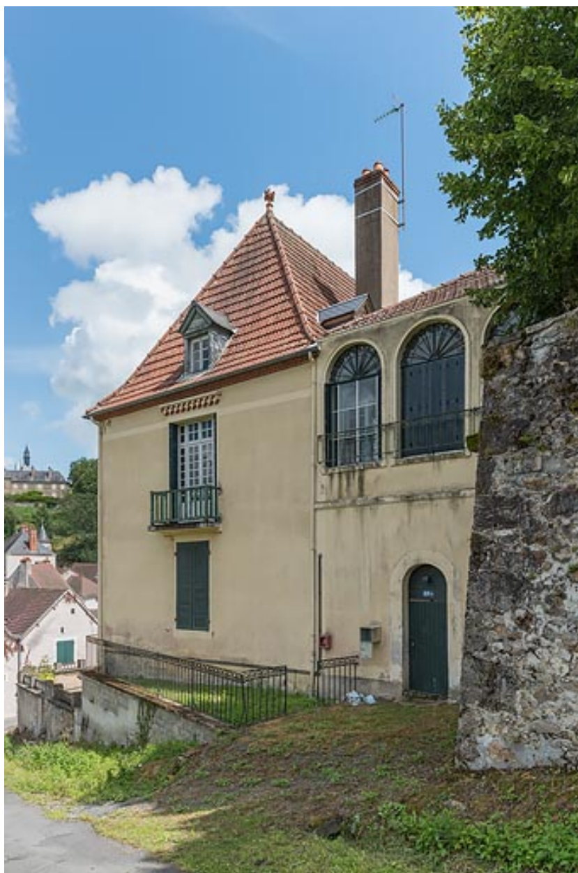
Vue depuis la rue de La Roche.
