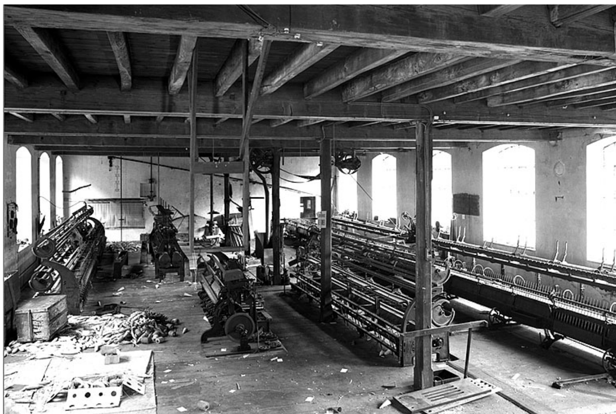
Vue d'ensemble des machines. De gauche à droite, machines Ryo-Catteau (moulineuse et assembleuse étudiées, moulineuse non étudiée) et machine Fouvez (moulineuse non étudiée). Tout à droite, renvideur Asa Lees.
