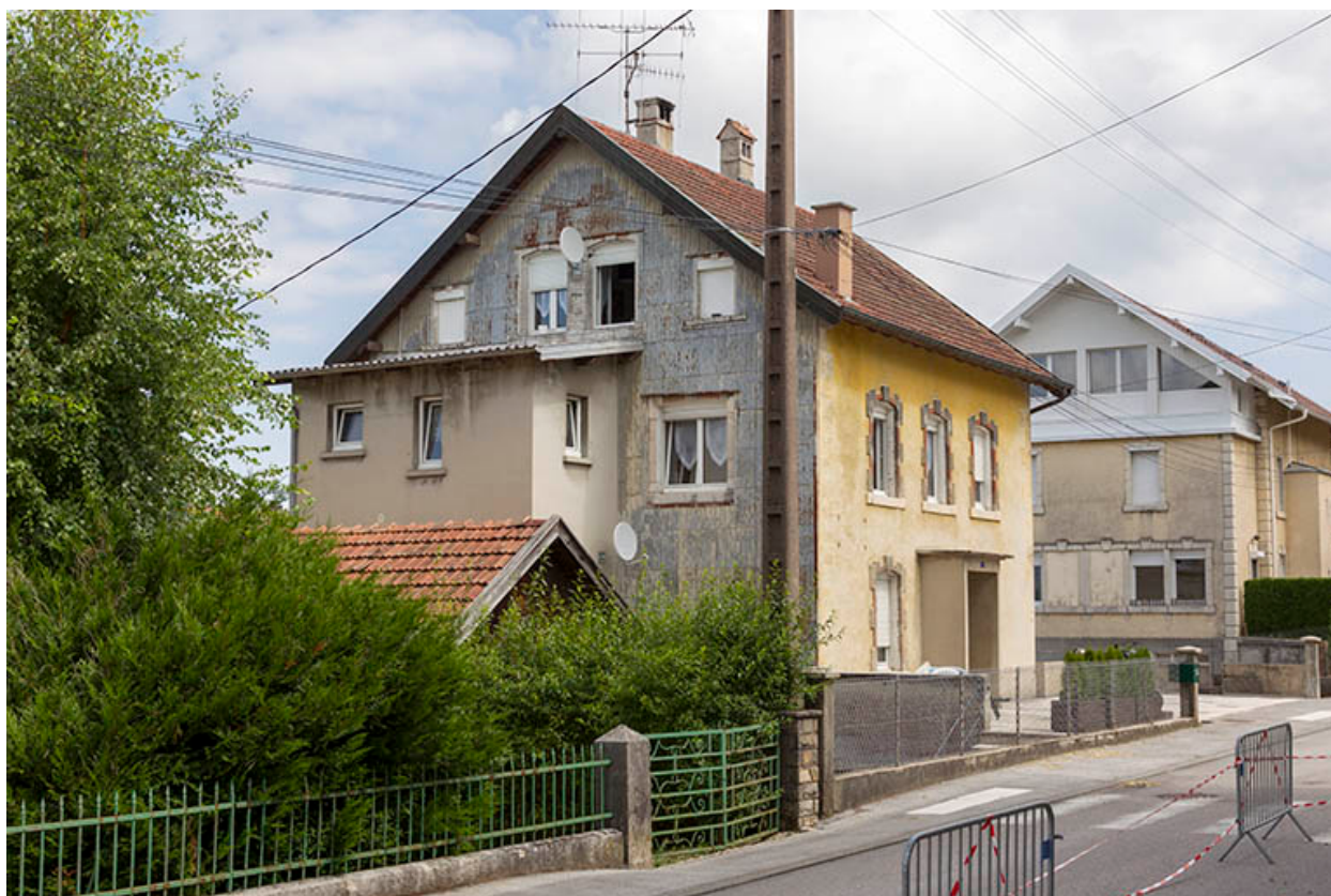
Façades antérieure et latérale gauche.
