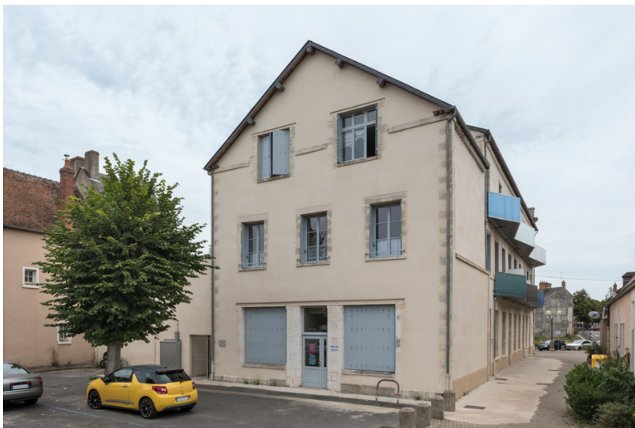
Façades postérieure et latérale gauche.
