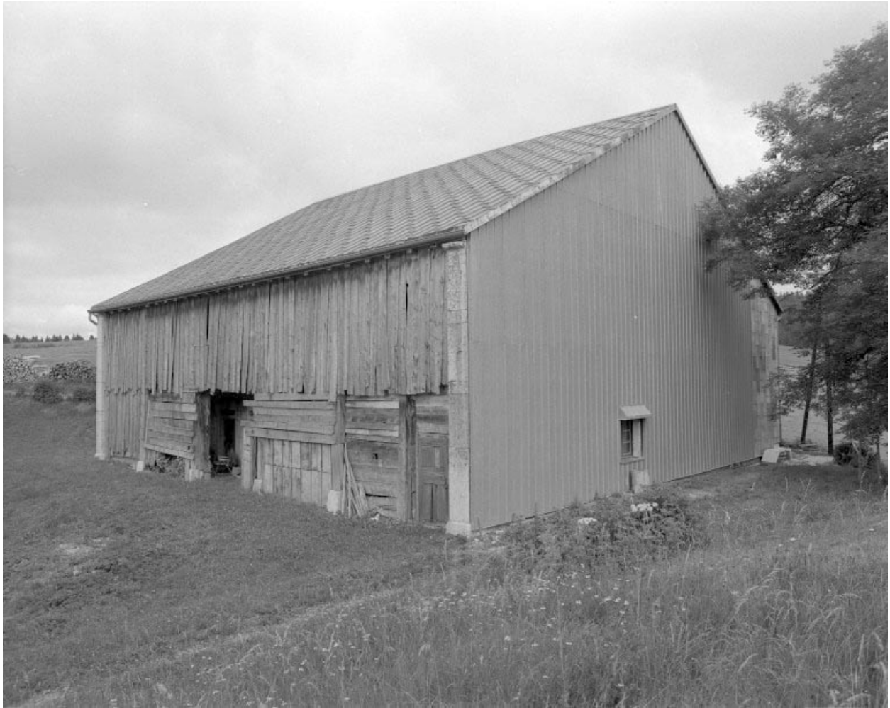
Façade postérieure et face gauche recouverte d'un essentage métallique.
