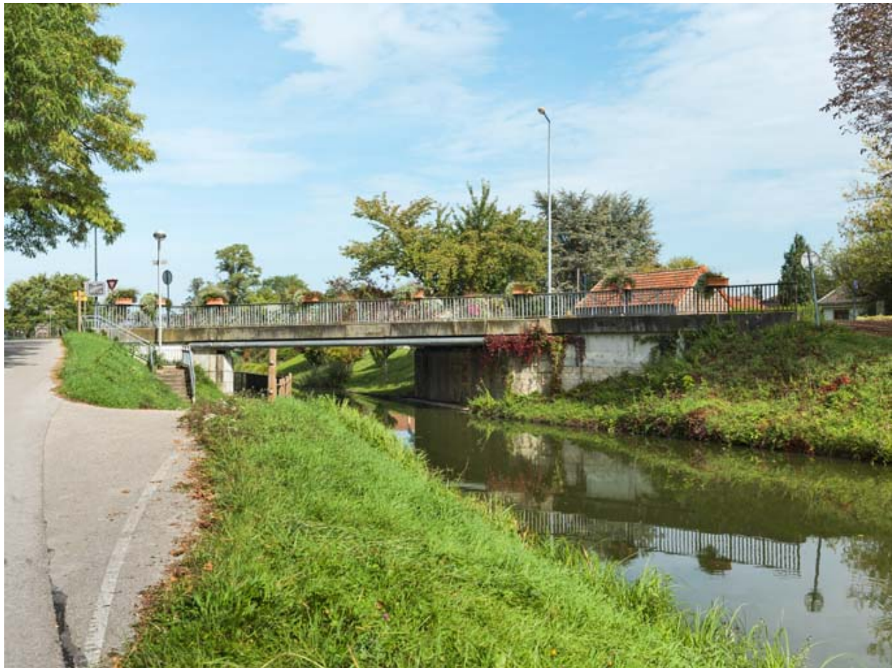
Vue d'ensemble du pont.
