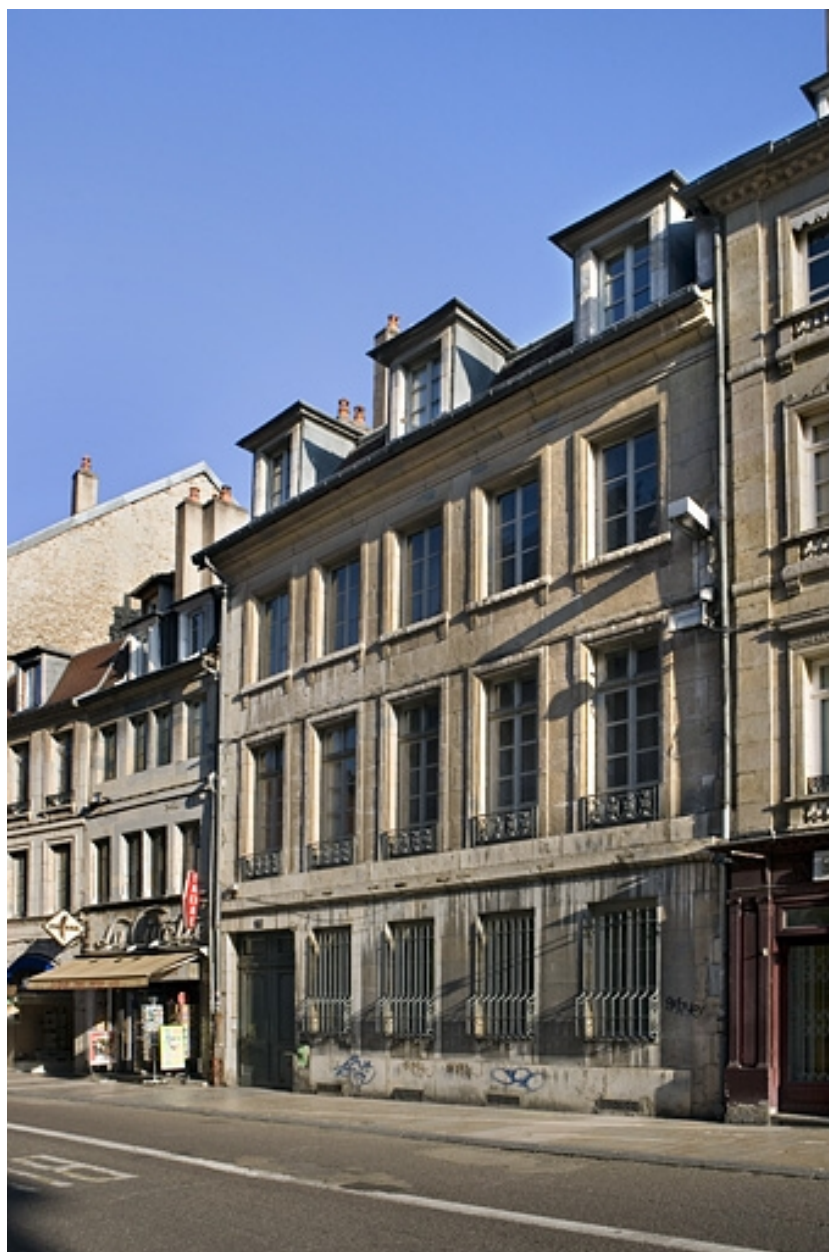
Vue d'ensemble du logis principal sur rue.
