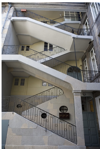
Vue d'ensemble de l'escalier à cage ouverte.
