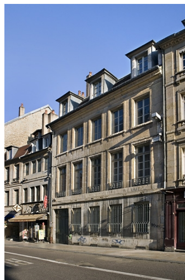
Vue d'ensemble du logis principal sur rue.
