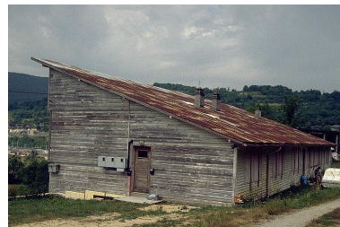
Façade antérieure. Phot. Jérôme Mongreville IVR43_19913900971ZA
