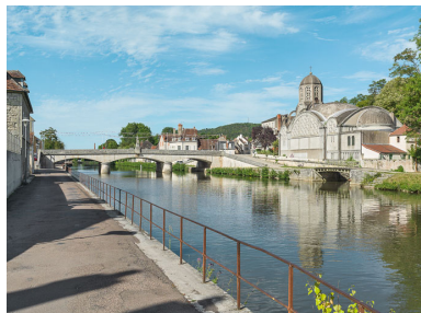
Vue du pont et de l'église Notre-Dame-de-Bethléem. Phot. Pierre-Marie Barbe-Richaud IVR26_20175800422NUC2A
