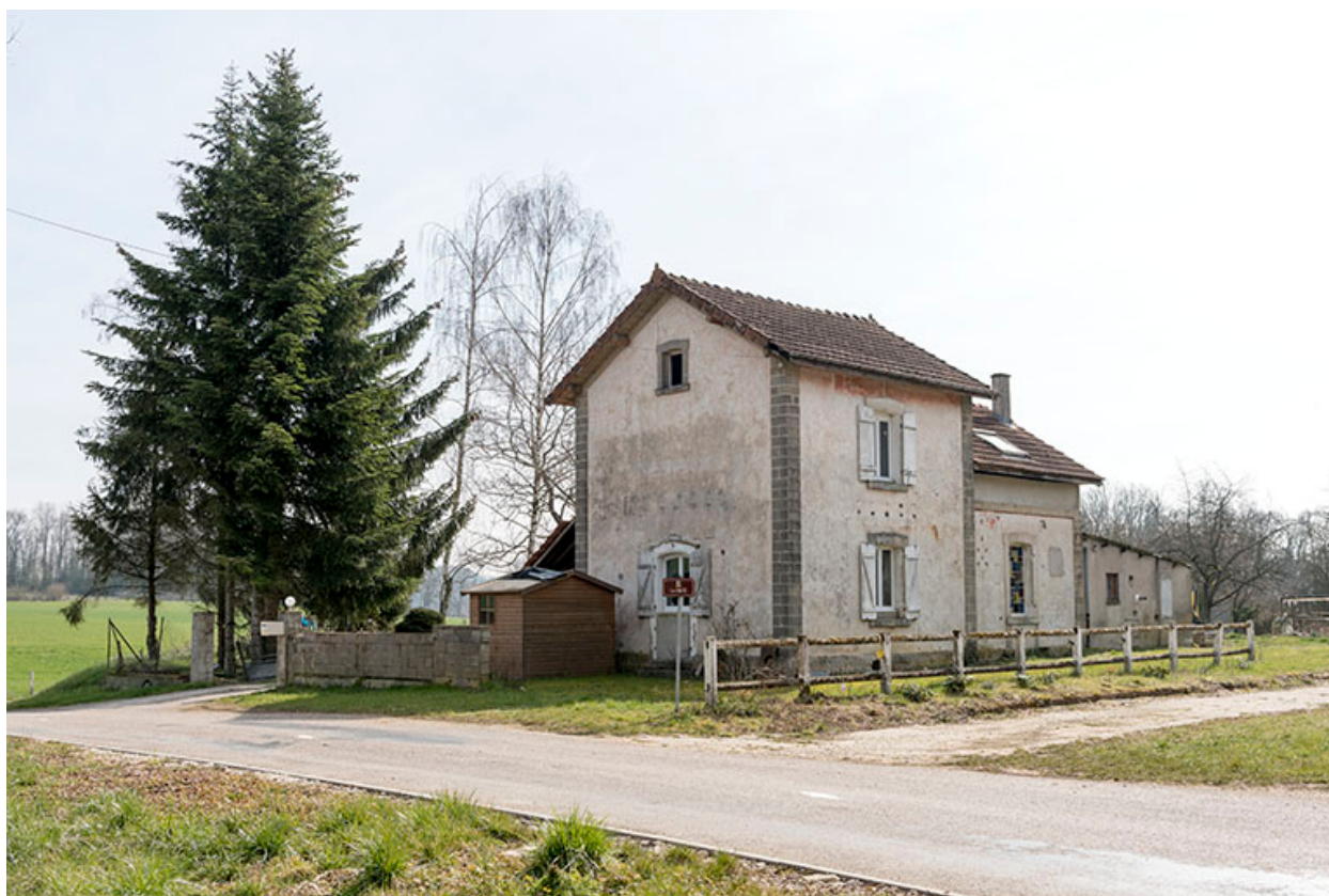
Maison garde-barrière entre Aisey et Bétaucourt.
