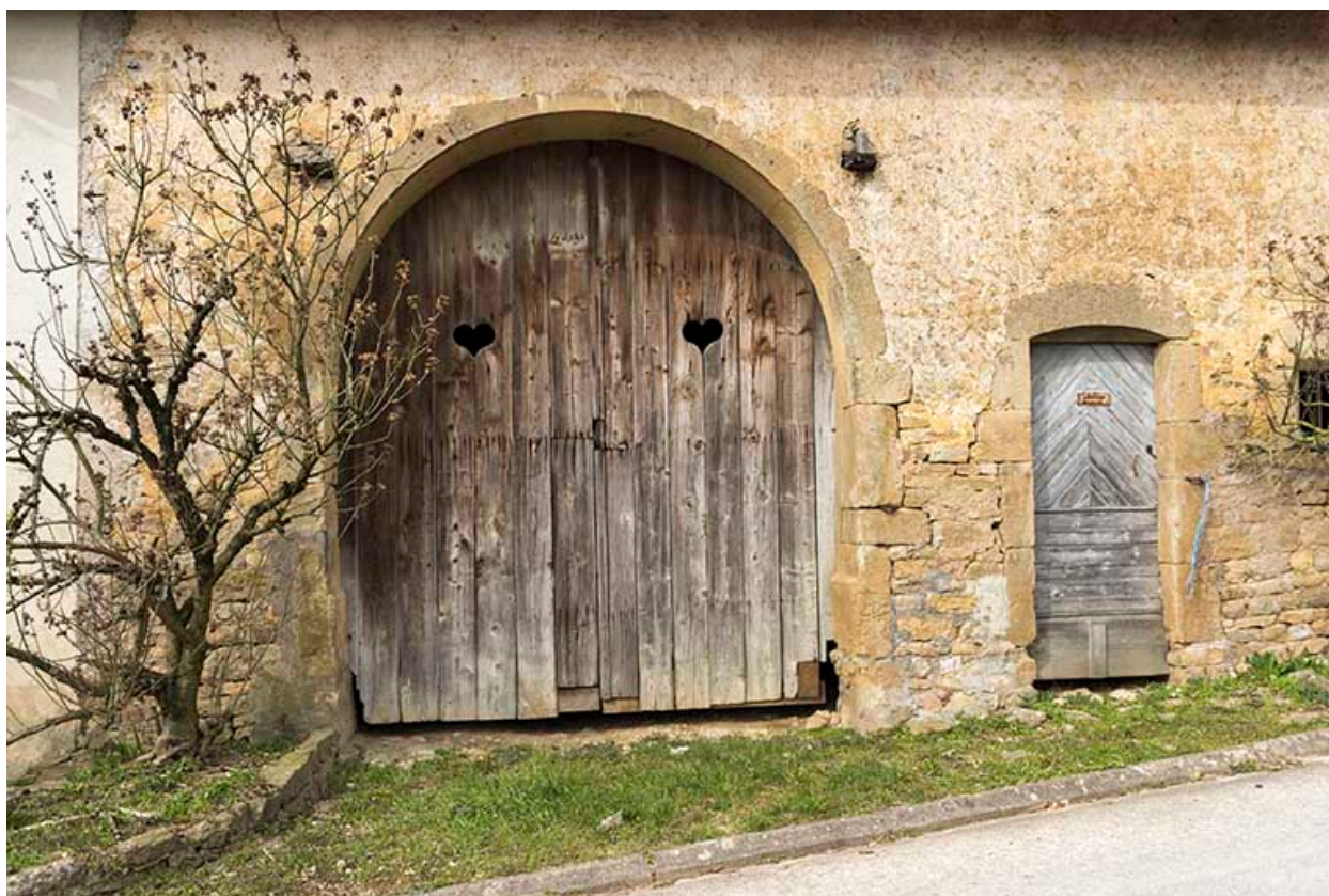
Entrée d'une grange à Aisey.
