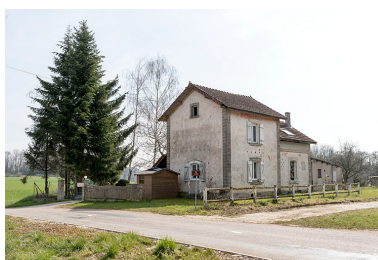
Maison garde-barrière entre Aisey et Bétaucourt. Phot. Sonia Dourlot IVR43_20167000590NUC4A
