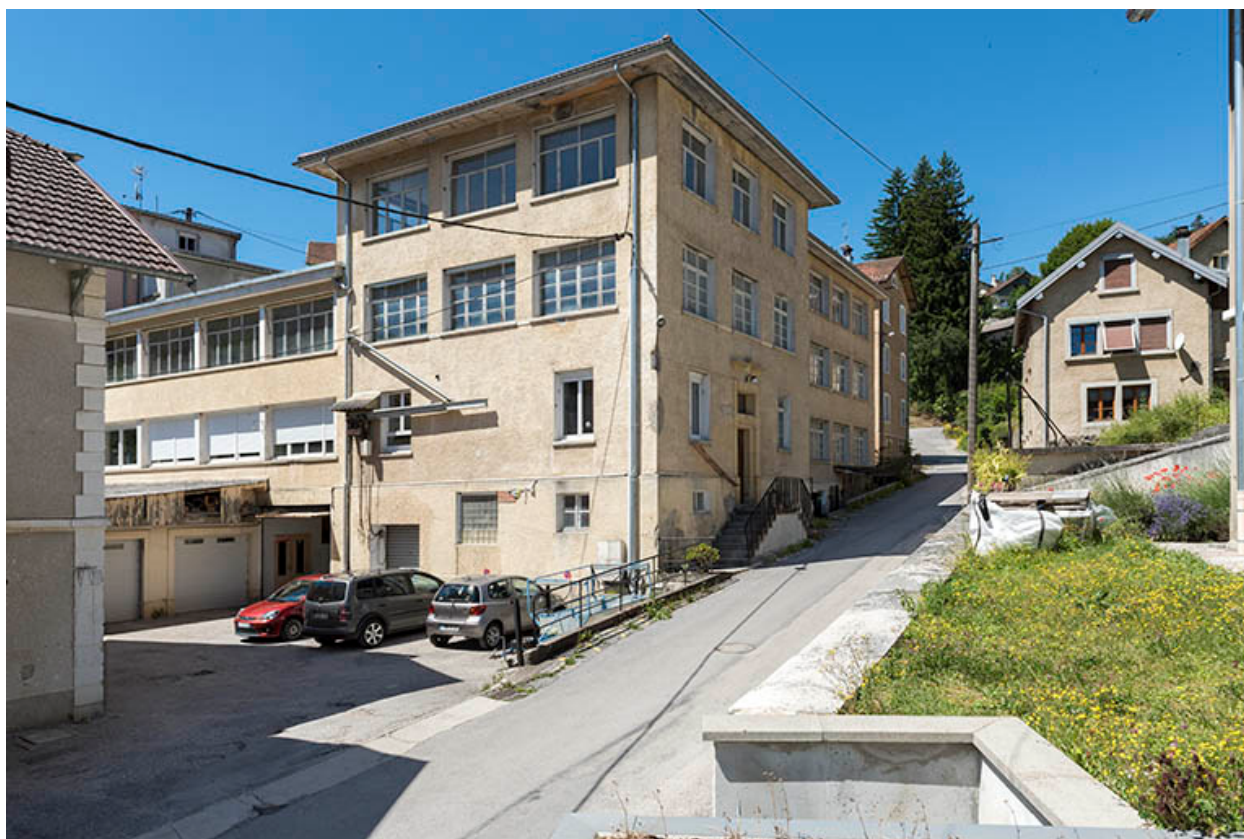
Usine : façades antérieure et latérale gauche.
