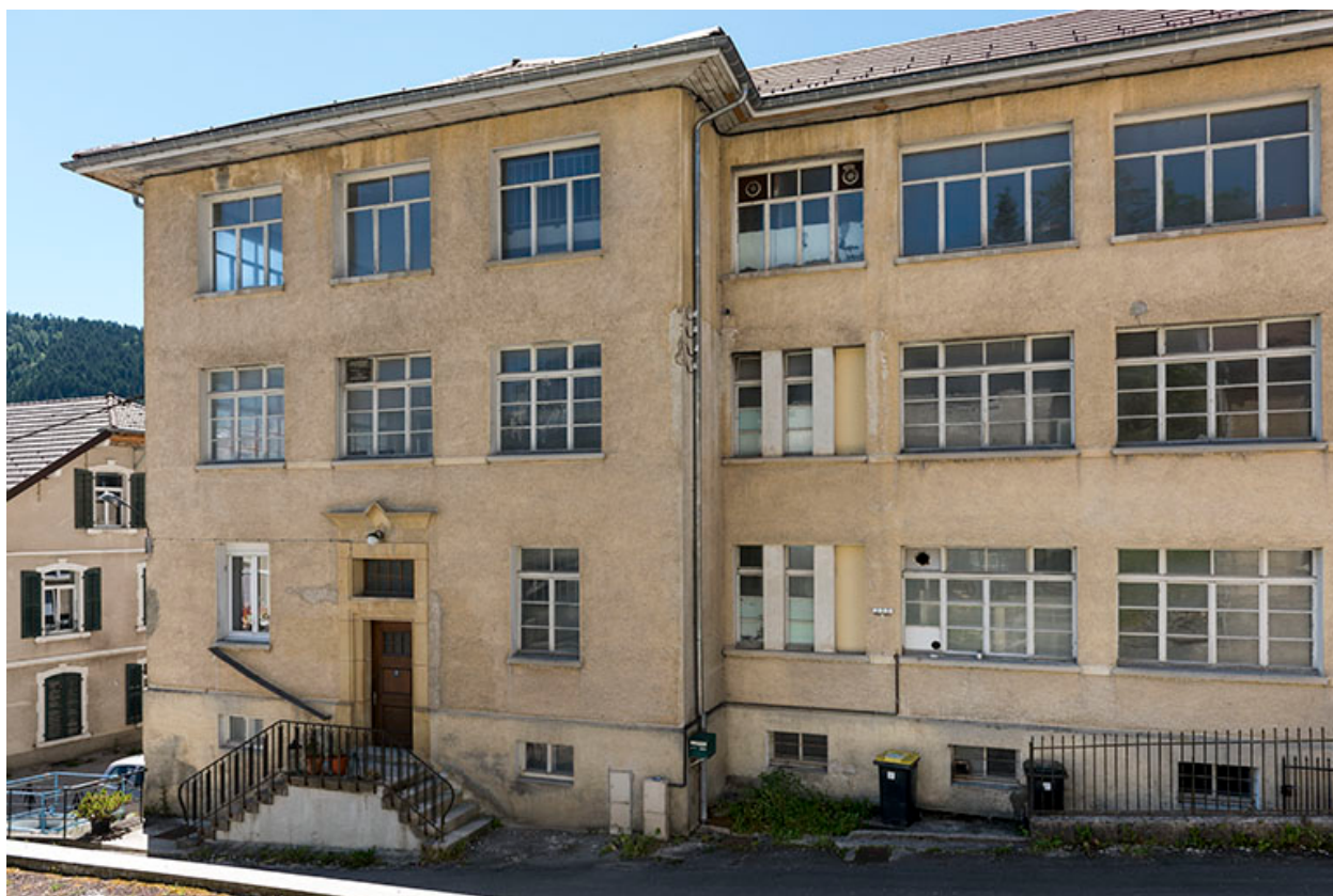
Usine : façade antérieure.
