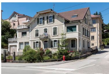
Vue d'ensemble, depuis l'est (maison au premier plan, usine à l'arrière-plan). Phot. Sonia Dourlot IVR43_20162501366NUC4A
