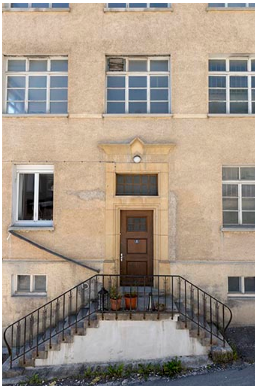
Usine : entrée sur la façade antérieure.
