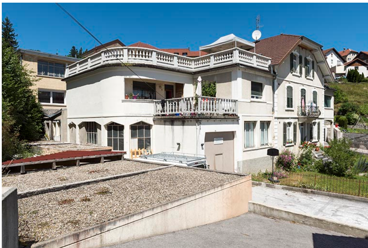
Maison : façades antérieure et latérale gauche.
