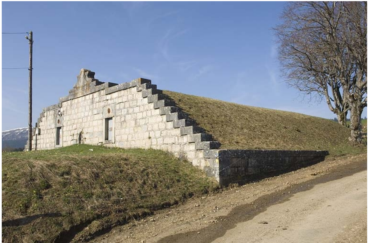
Réservoir du Mont Ramey.
