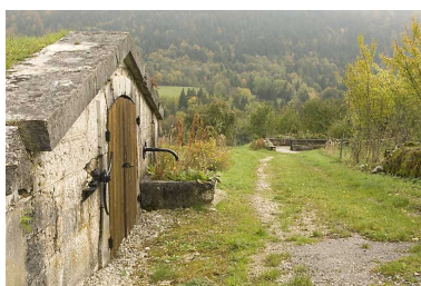
Réservoir des Maillots : façade vue en enfilade.
