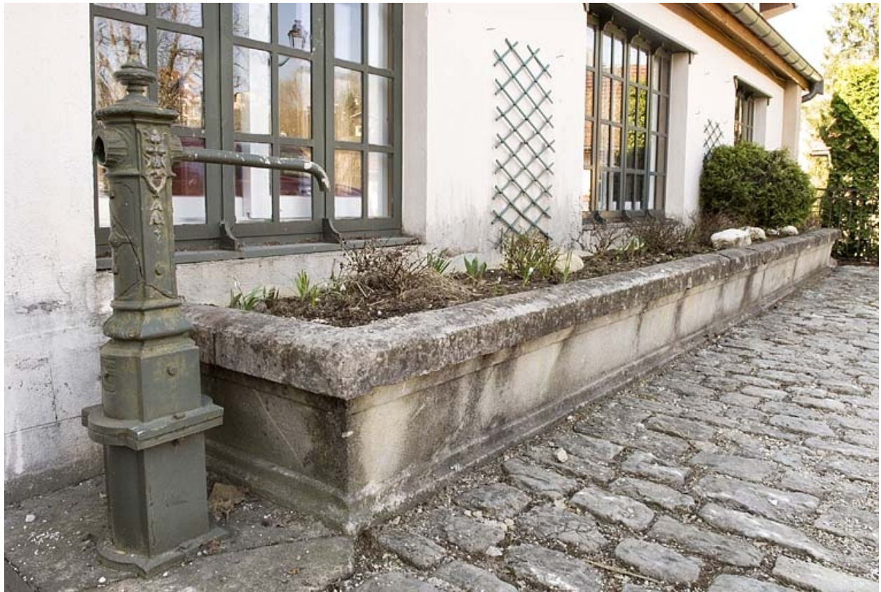
Fontaine-lavoir-abreuvoir de la Porte ou du Centre.
