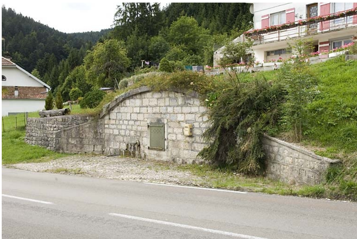
Réservoir des Tavins (route de Vallorbe, 2008 AH 16).
