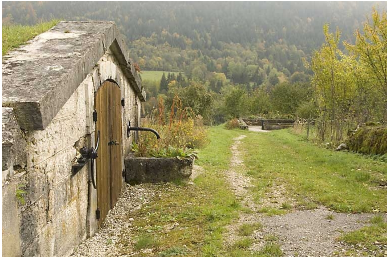
Réservoir des Maillots : façade vue en enfilade.
