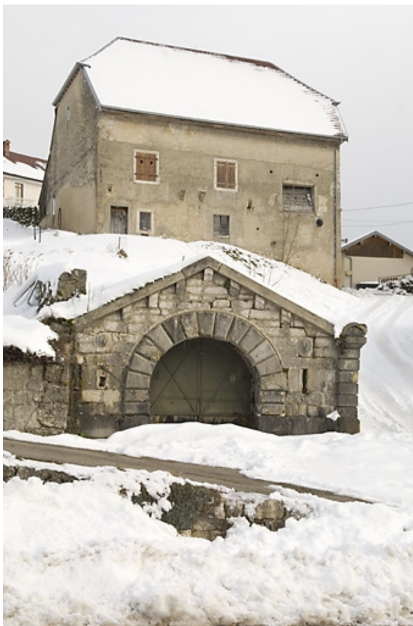
Réservoir des Portes, en hiver.
