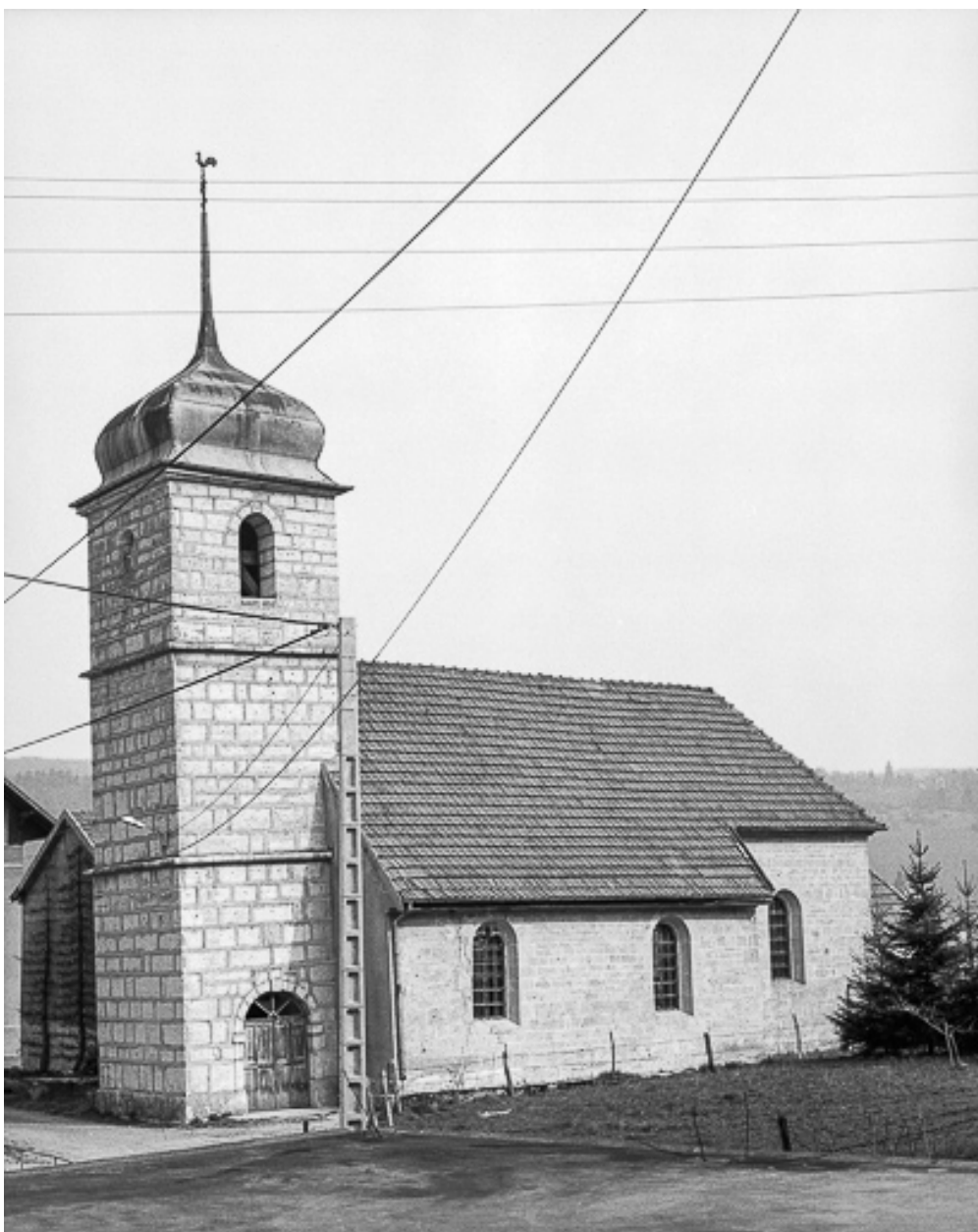
Face sud vue depuis le sud-ouest.
