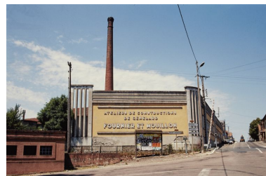
vue g  n  rale du mur sur le long de la voie de chemin de fer et de la rue Nationale. Phot. Jean-Luc Duthu IVR26_20007100300ZA
