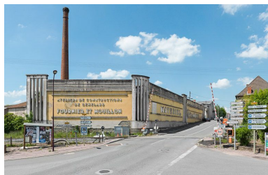
Vue d'ensemble des b  timents de l'usine. Phot. Pierre-Marie Barbe-Richaud IVR26_20137100459NUC4AQ
