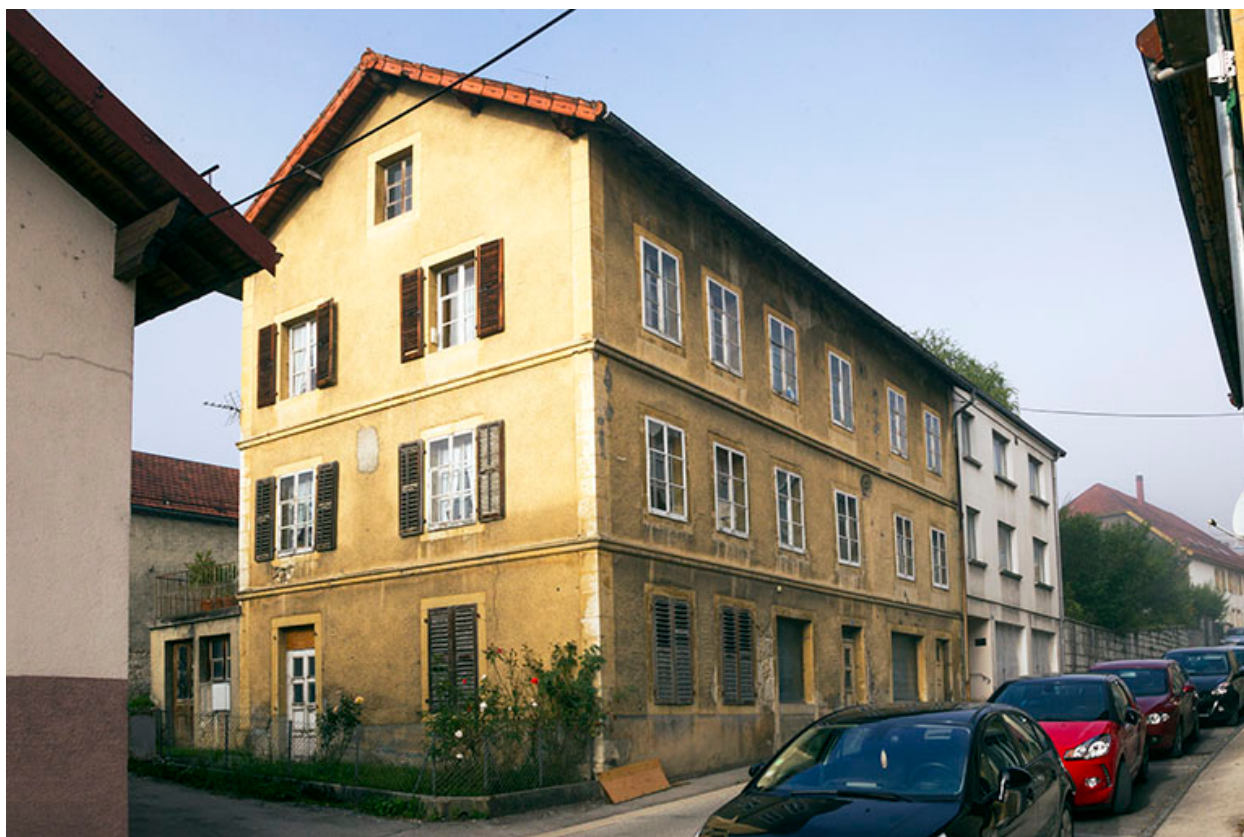
Façades antérieure et latérale gauche.
