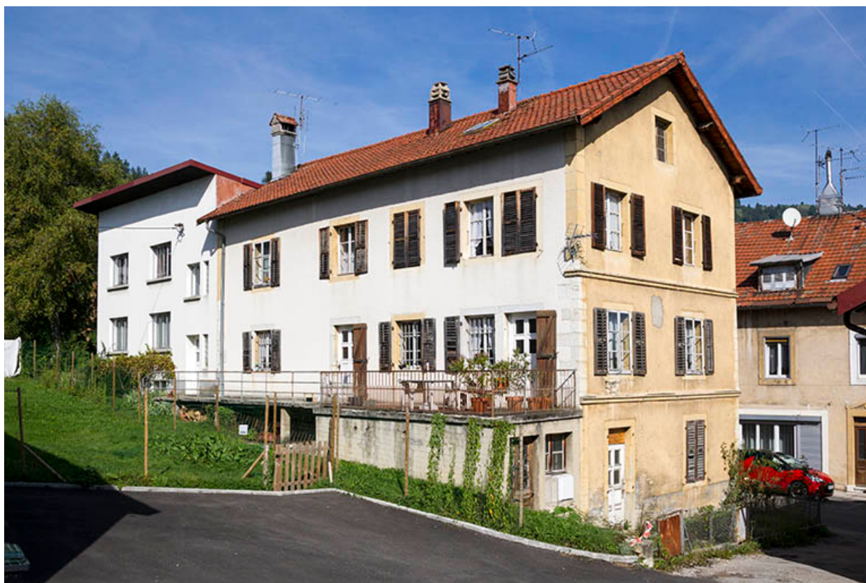
Façades postérieure et latérale gauche.
