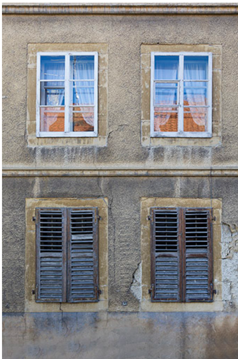
Maison : fenêtre de la façade antérieure.
