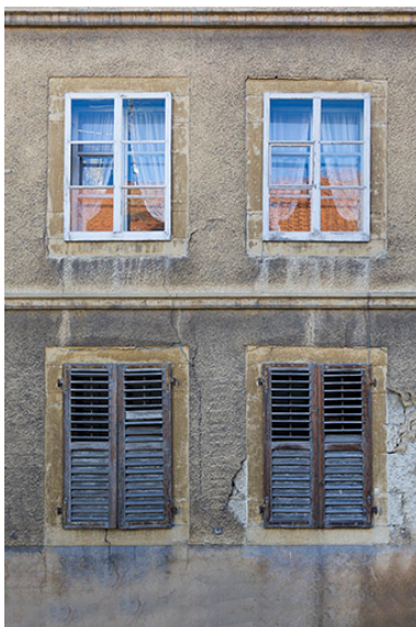
Maison : fenêtre de la façade antérieure.
