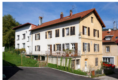
Façades postérieure et latérale gauche.
