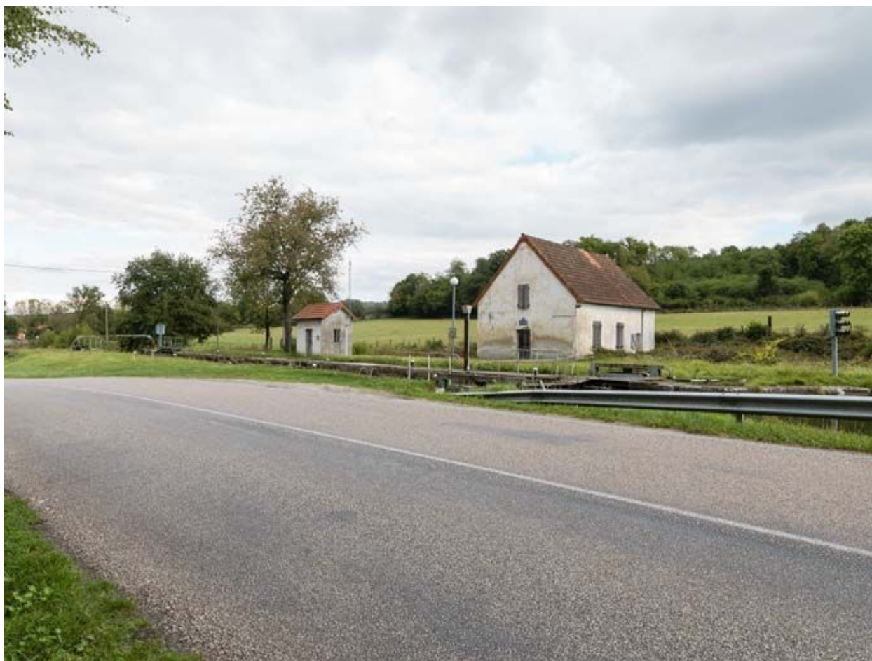
Vue d'ensemble du site d'écluse.
