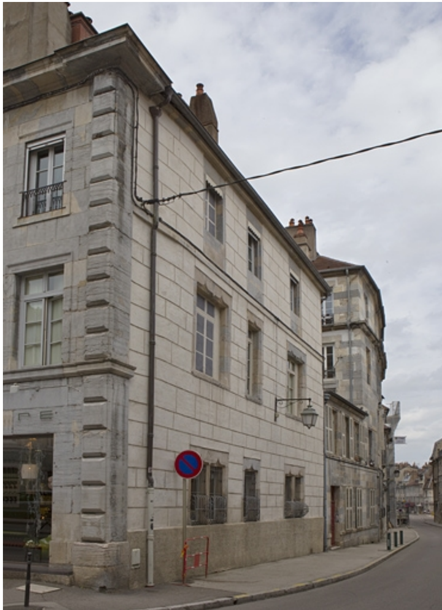
Vue d'ensemble de la façade latérale droite.
