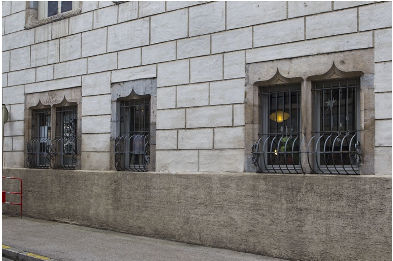
Façade latérale droite, détail du rez-de-chaussée.
