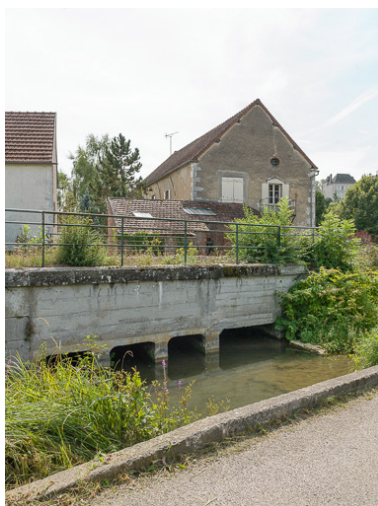
Vue de l'aqueduc.
