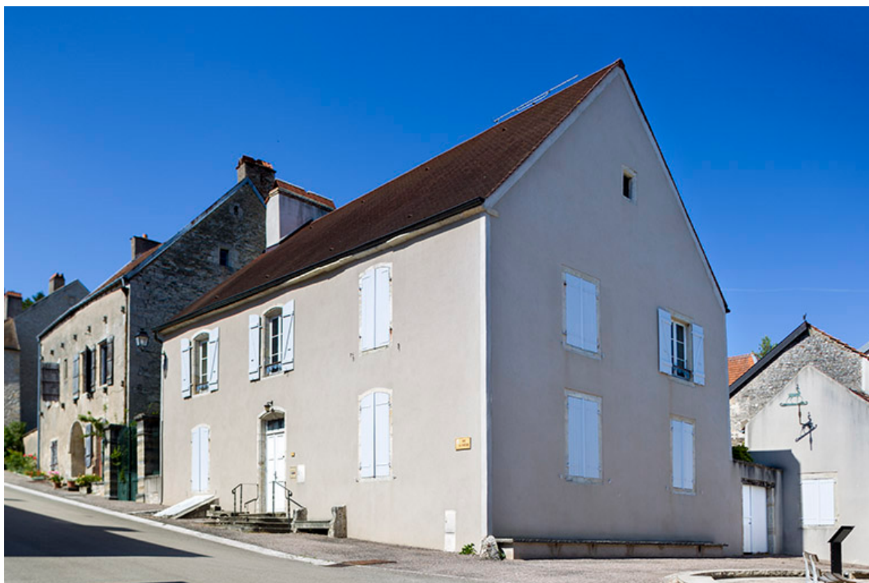
Vue générale de trois quart droite.
