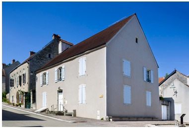
Vue générale de trois quart droite.
