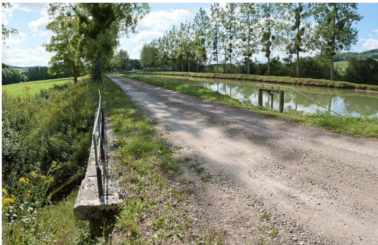
Vue du déversoir.
