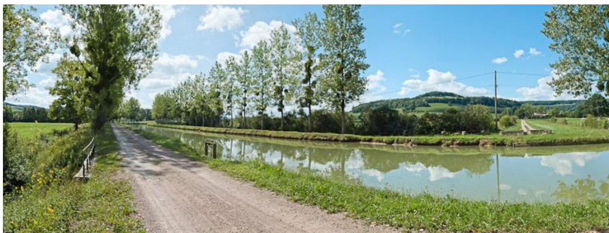
Vue du déversoir.
