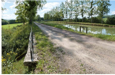
Vue du déversoir. Phot. Pierre-Marie Barbe-Richaud IVR26_20112104006NUC2AQ
