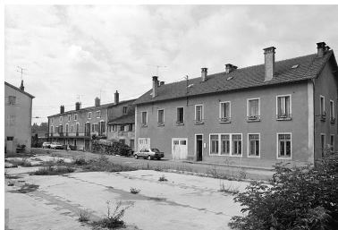
Au premier plan, traces d'un entrepôt détruit en 1988 ; au fond logements gauches. Phot. Yves Sancey IVR43_19887000157X
