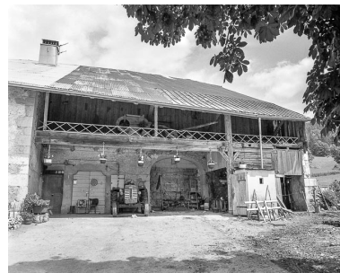
Une ferme avec portes d'entrées sur goutterot. Phot. Dominique Dominguez IVR43_19792500969X
