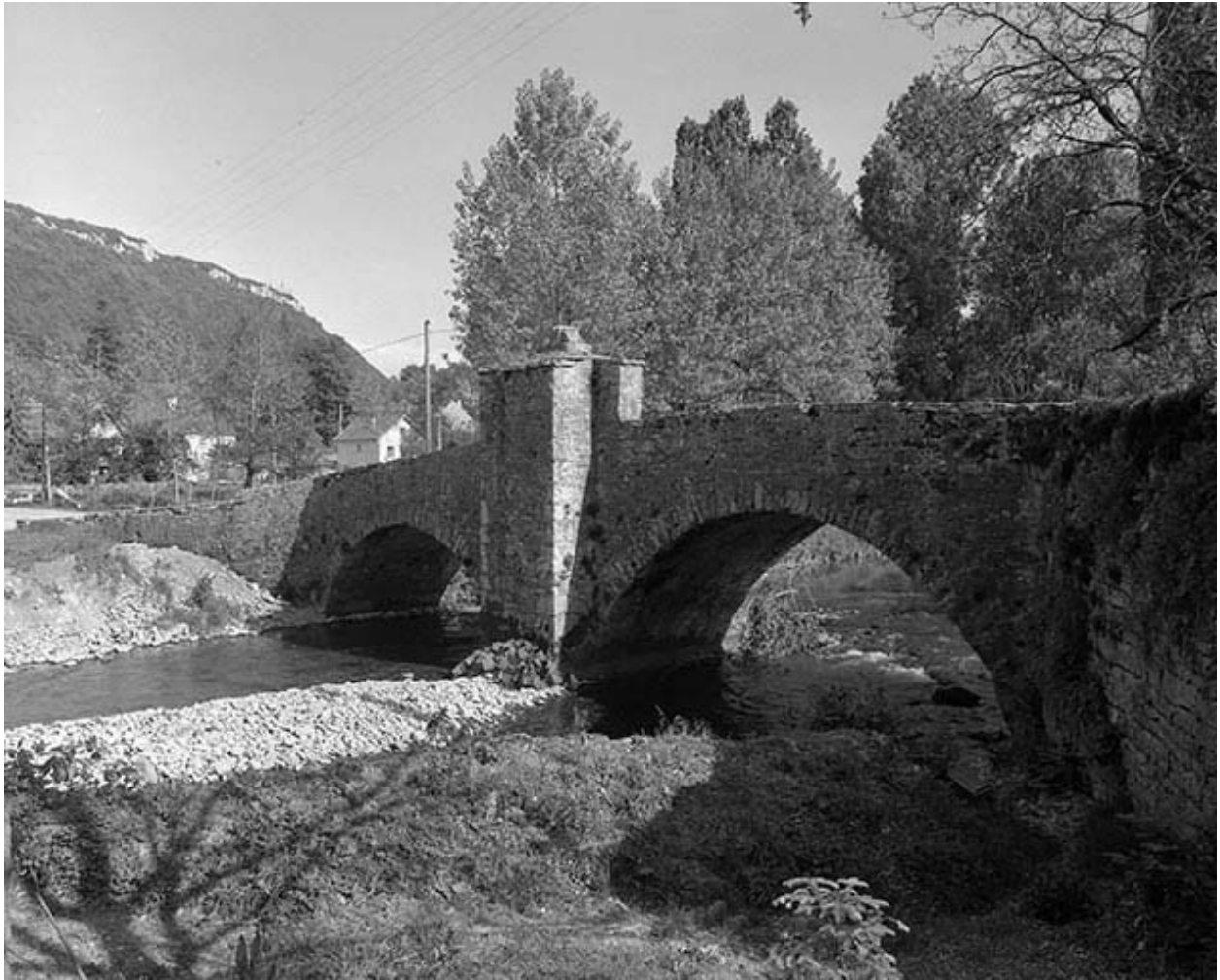
Face aval de trois quarts droit.
