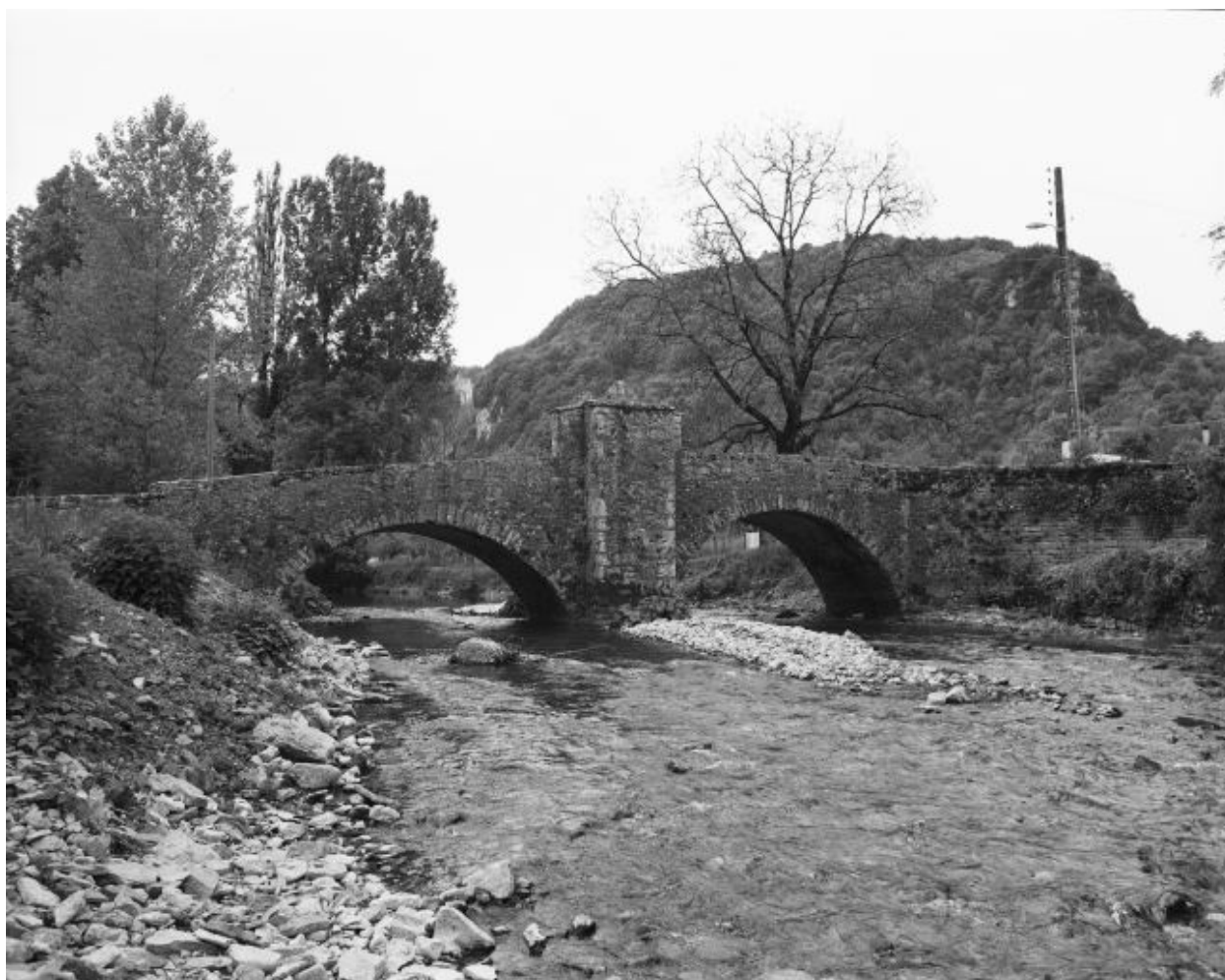
Face aval vue de trois quarts.
