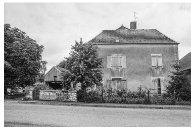
Façade antérieure de l'habitation. Phot. Bernard Lardière IVR43_19817000263Z
