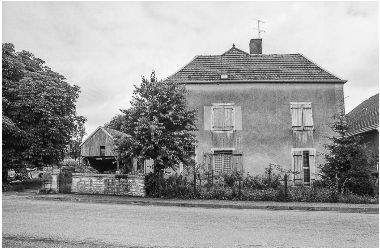
Façade antérieure de l'habitation.
