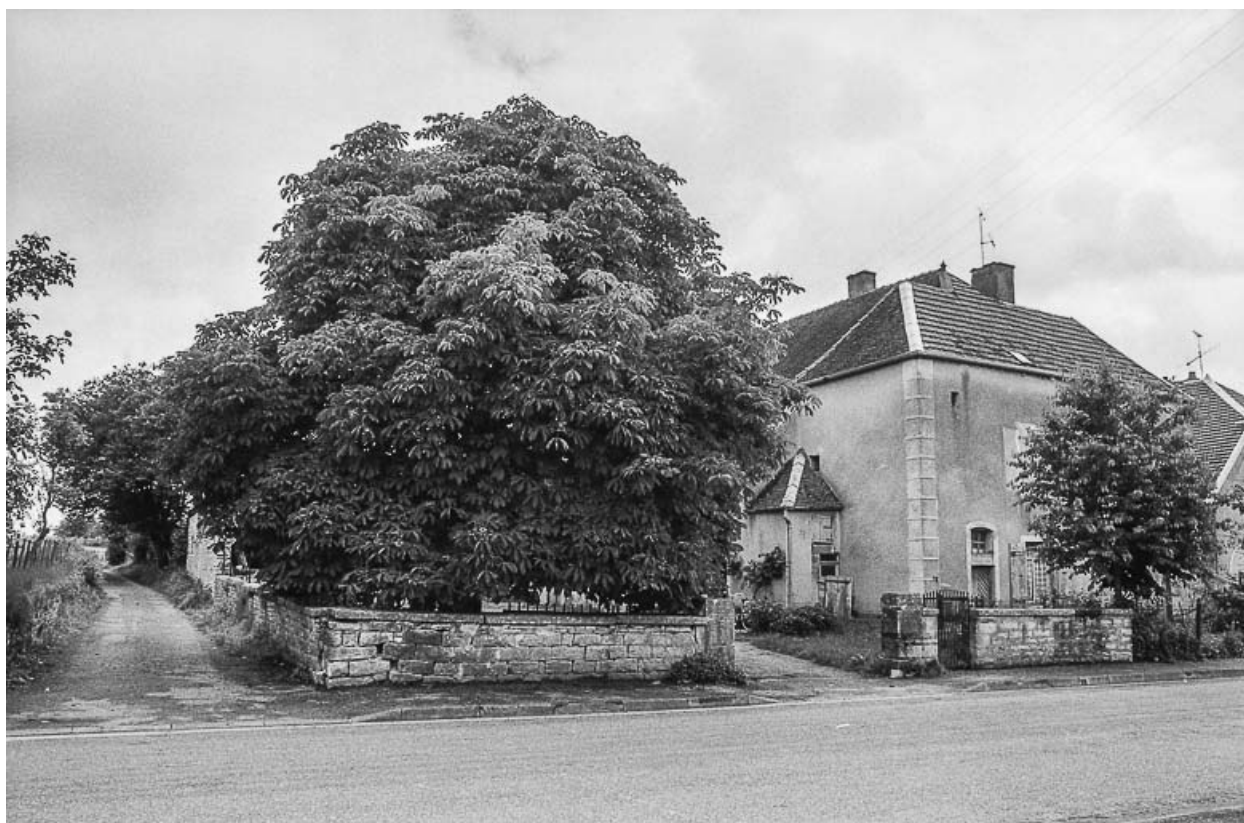
Vue d'ensemble depuis la rue.
