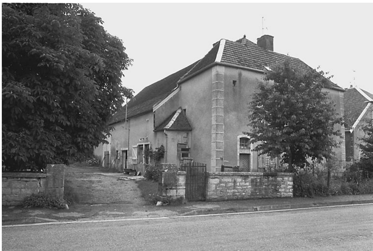
Vue du bâtiment de trois quarts gauche.
