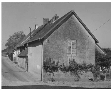
Ferme située 34 Grande Rue. Phot. Yves Sancey IVR43_19803900033X
