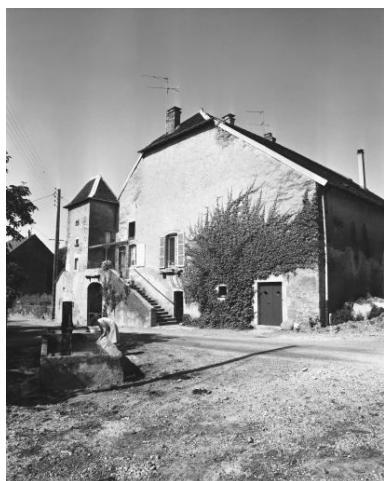
Ferme située 9 Grande Rue. Phot. Dominique Dominguez IVR43_19803900038X
