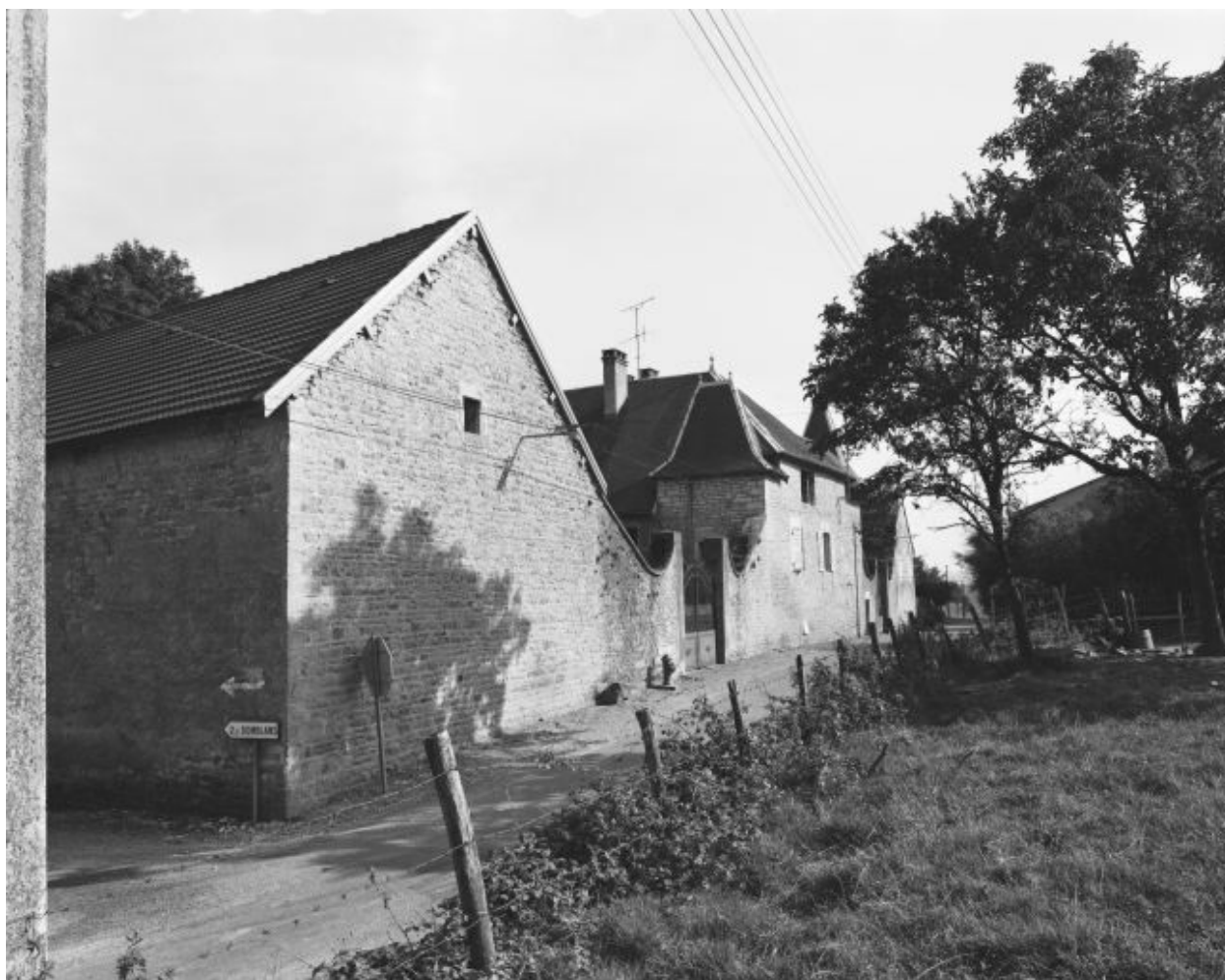
Demeure située rue du Moulin.
