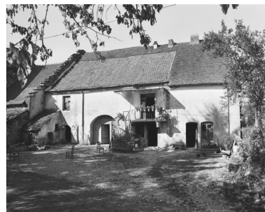
Ferme située Grande Rue. Phot. Dominique Dominguez IVR43_19803900031X
