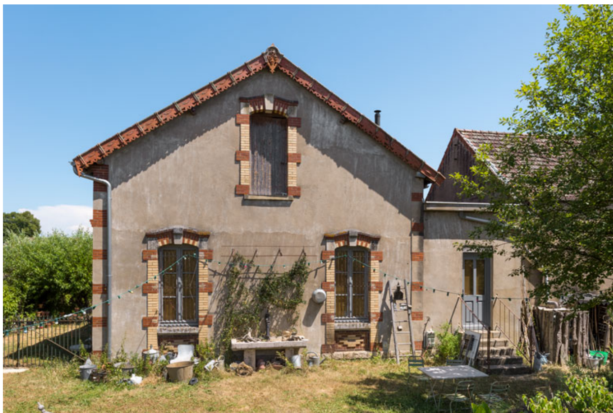
Salle de bal : façade latérale droite.
