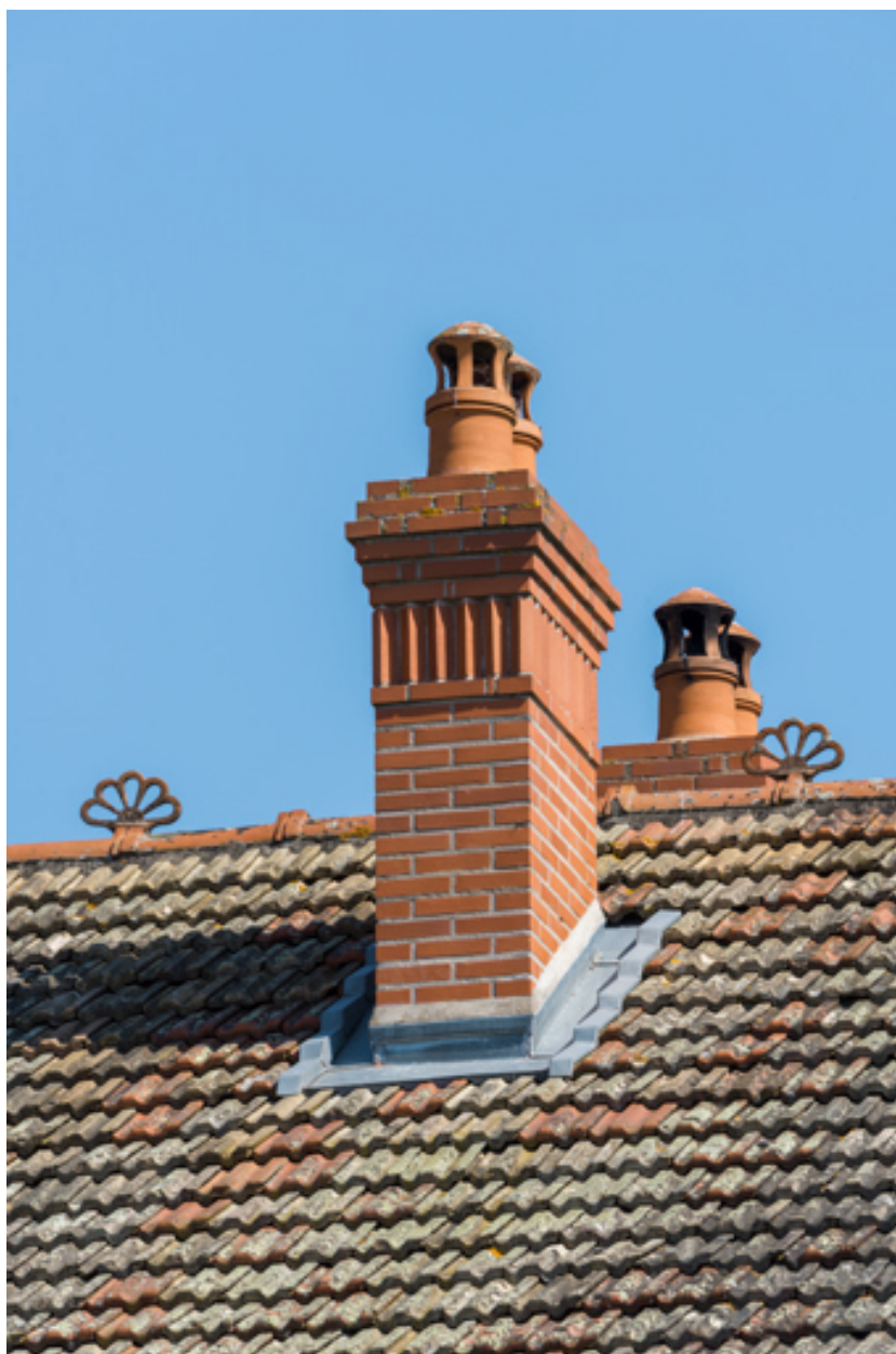
Hôtel-restaurant : souches de cheminée.
