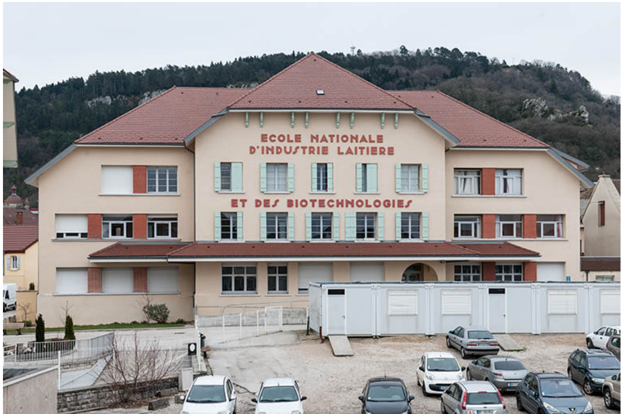
Façade antérieure ouest de l'école.
