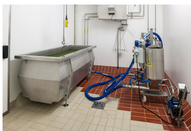
Détail d'atelier. Phot. Jérôme Mongreville IVR43_20143900145NUC4A
