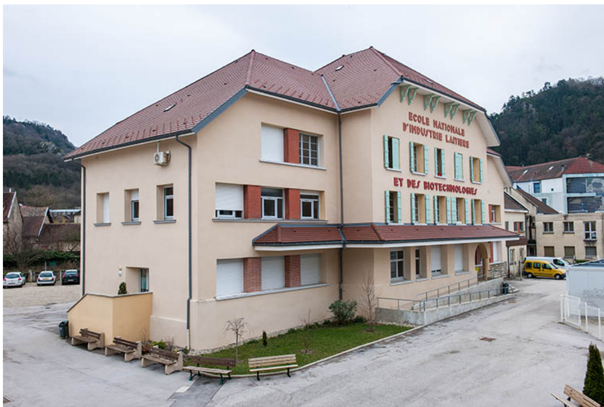
Façade antérieure principale de l'école, angle nord-ouest.
