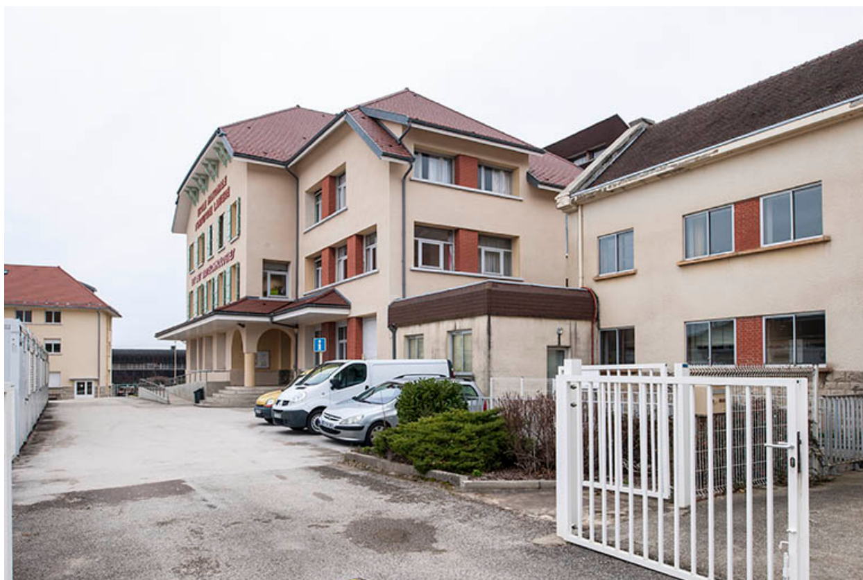
Façade antérieure ouest de l'école.
