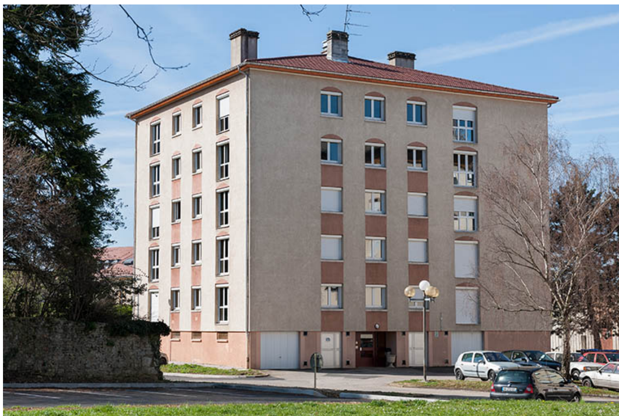
Angle nord-est, entrée du bâtiment des pinsons.
