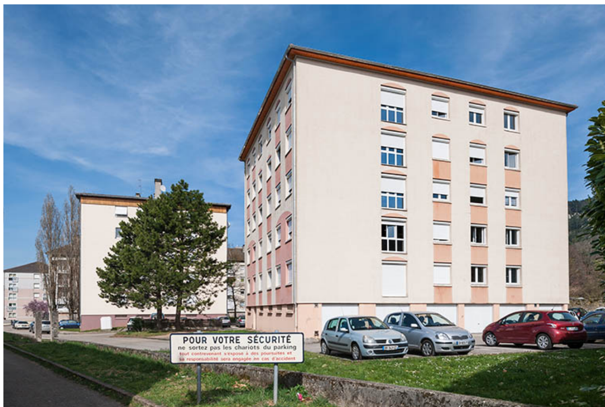
Angle sud-ouest du bâtiment des pinsons.
