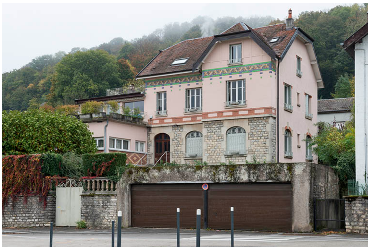
Usine Alber (1929-1930), 11 rue de la Grette.
