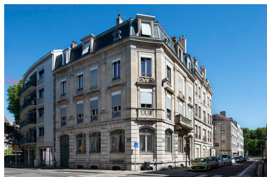
Immeuble et atelier Gondy (vers 1894), 17-19 rue Gambetta. Phot. Jérôme Mongreville IVR43_20182501306NUC4A
