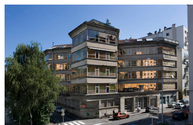
Usine Sidhor (1947-1948), 23 rue de la Mouillère. Phot. Yves Sancey IVR43_20062501177NUCA
