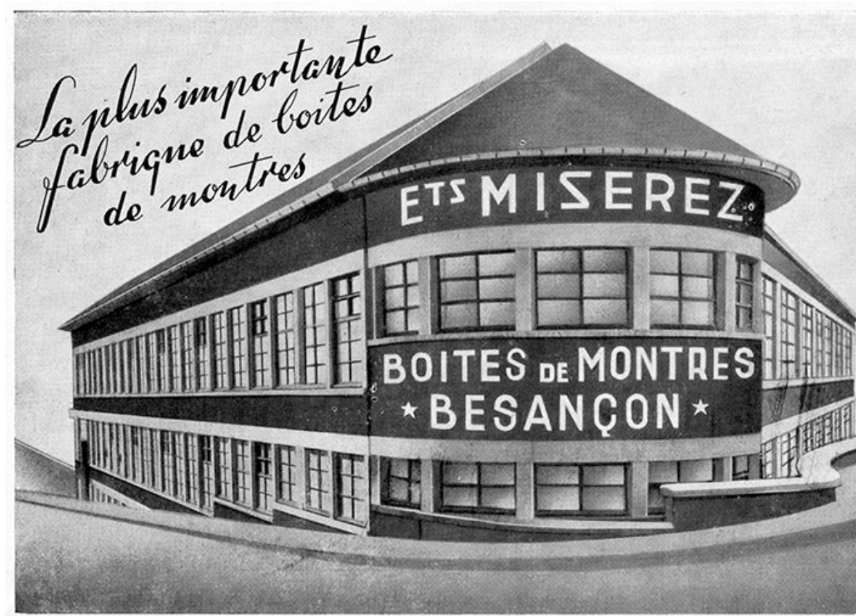
Usine de boîtes de montres Miserez, [1951].
