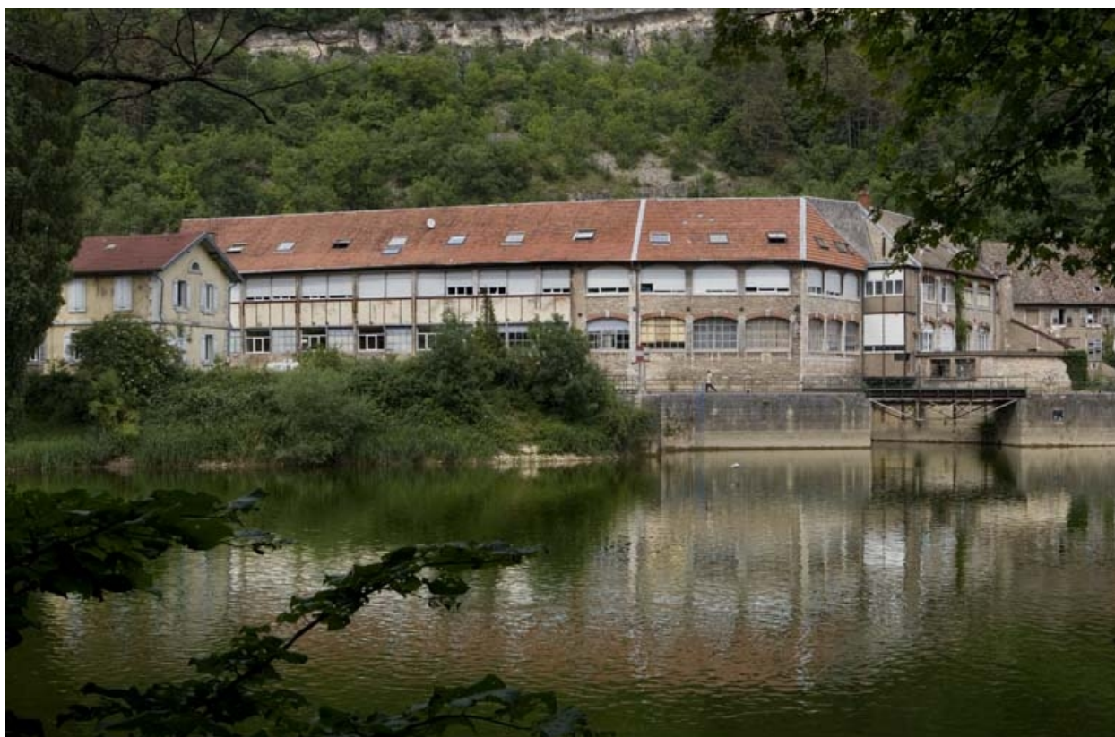
Moulin de Tarragnoz puis usines d'horlogerie Robert et Geismar (Ultra), 2-6 Faubourg Tarragnoz : ateliers côté Doubs (1890-1902).
