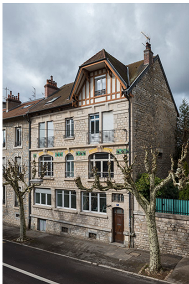
Maison et atelier d'horlogerie Bernardin-Rozat puis Pétolat Frères et Anguenot (vers 1910), 7 avenue Denfert-Rochereau. Phot. Jérôme Mongreville IVR43_20182500500NUC4A
