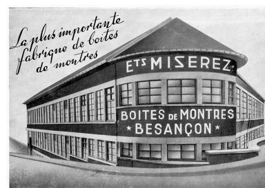
Usine de boîtes de montres Miserez, [1951].
