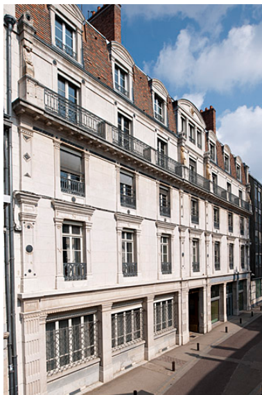
Immeuble et ateliers d'horlogerie (3e quart 19e siècle), 11 rue Gustave Courbet. Phot. Jérôme Mongreville IVR43_20112500093NUC4A
