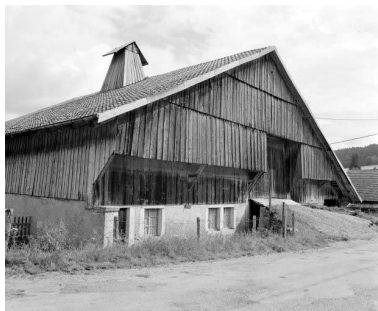
Ferme située au lieudit Les Jarrons. Phot. Yves Sancey IVR43_19772500411X
