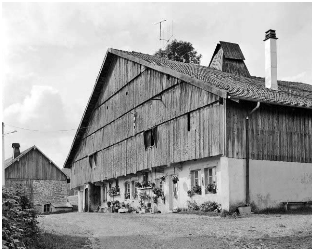
Ferme située au lieudit La Picarde.
