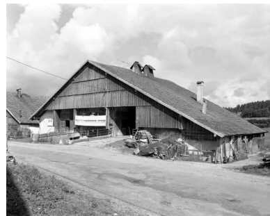
Ferme située au lieudit Les Jarrons. Phot. Yves Sancey IVR43_19772500424X
