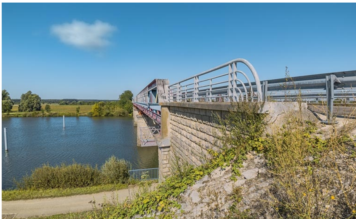
Vue d'ensemble du pont.
