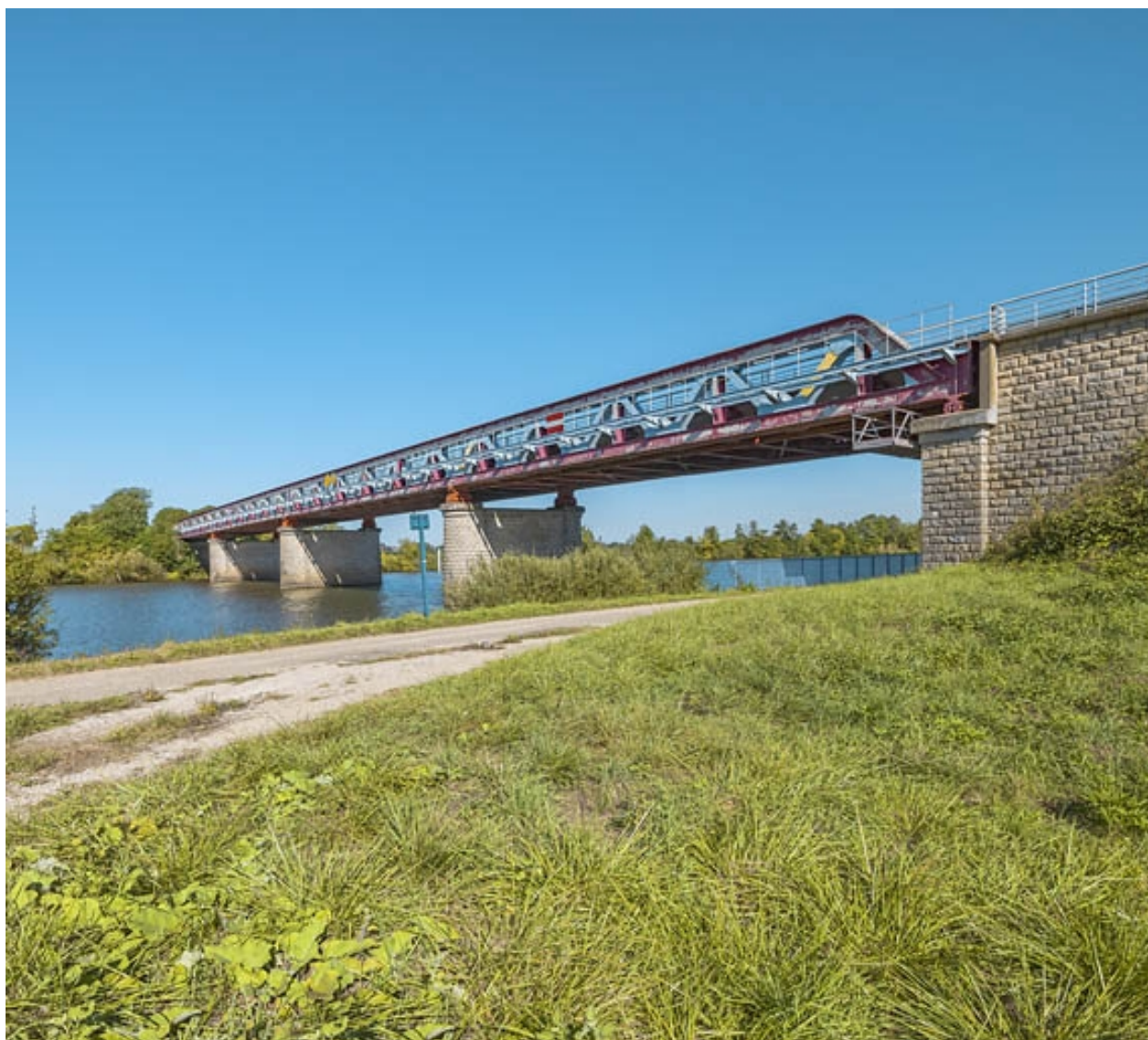
Vue d'ensemble du pont.
