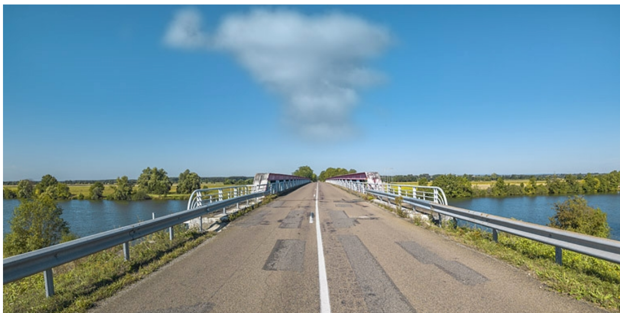
Vue d'ensemble du tablier du pont.
