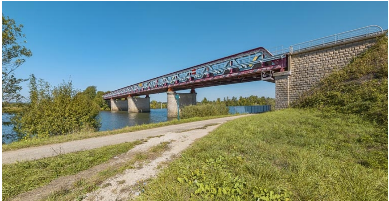
Vue d'ensemble du pont.
