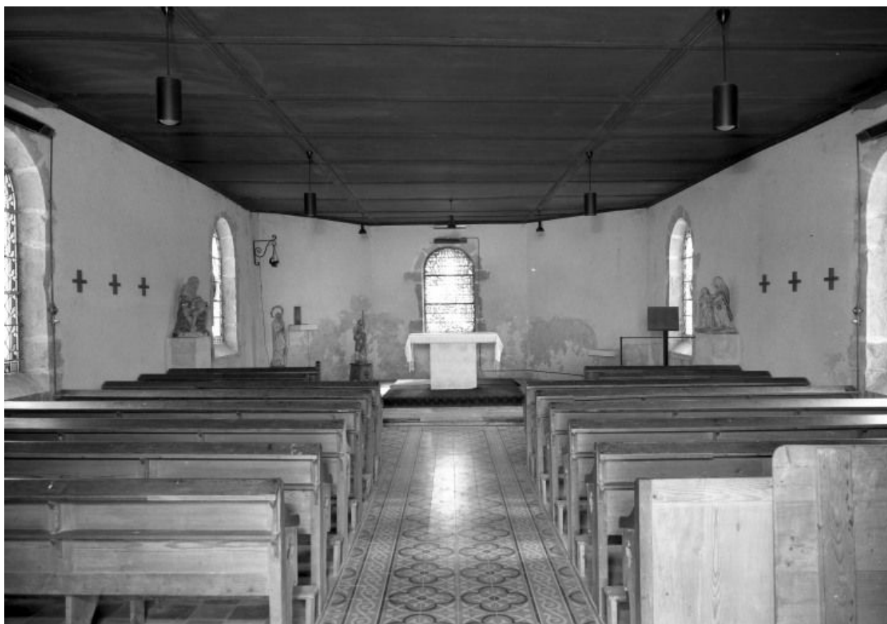
Vue intérieure prise de l'entrée
