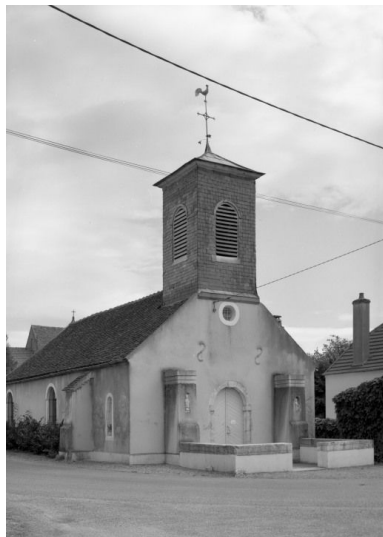
Elévations antérieure et gauche Phot. Jean-Luc Duthu IVR26_19852100439V
