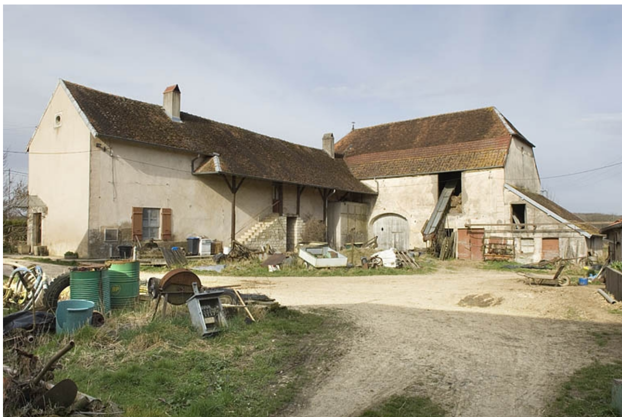
Vue de la ferme depuis l'est.
