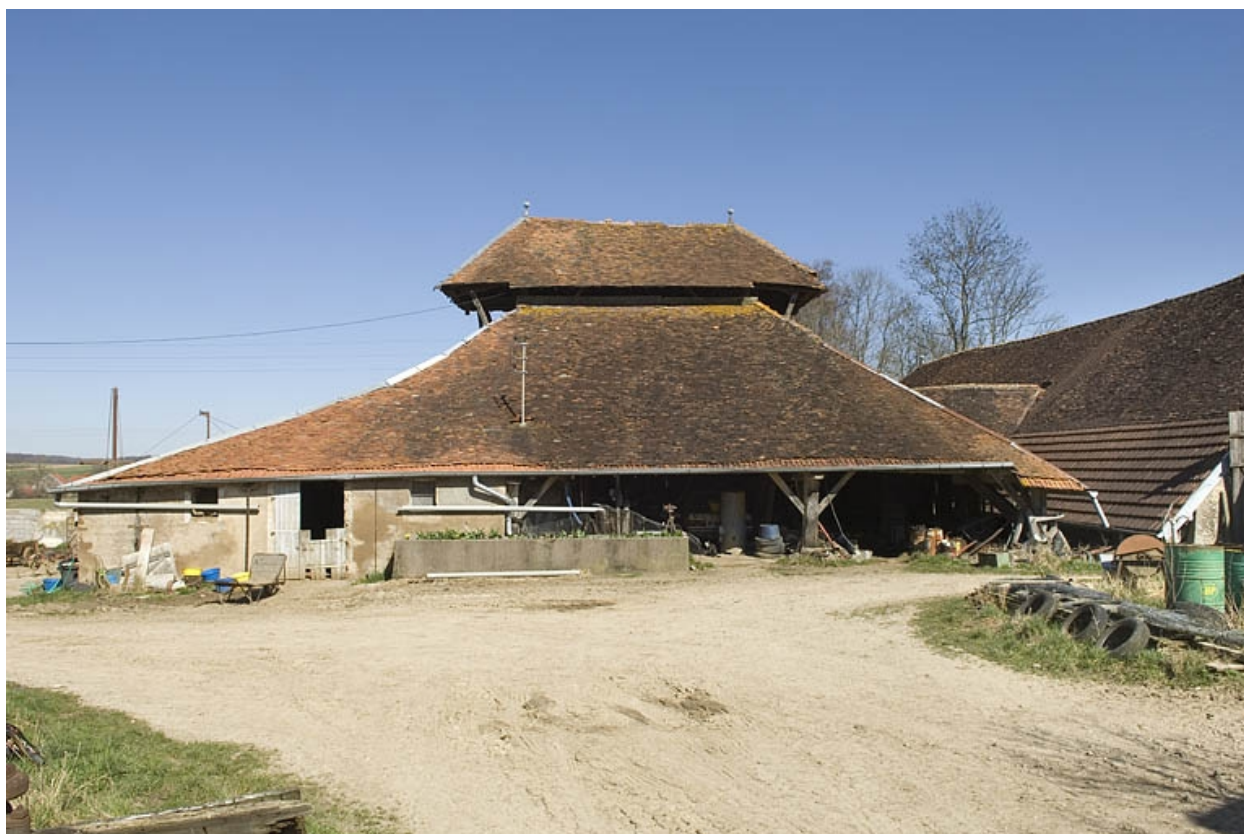
Bâtiment du four vu de face.
