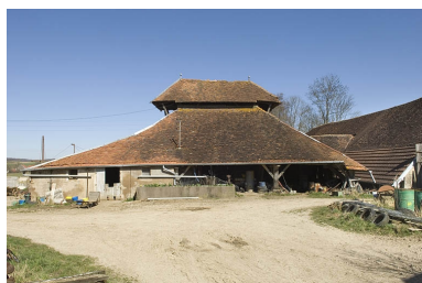
Bâtiment du four vu de face. Phot. Jérôme Mongreville IVR43_20097000140NUC2A
