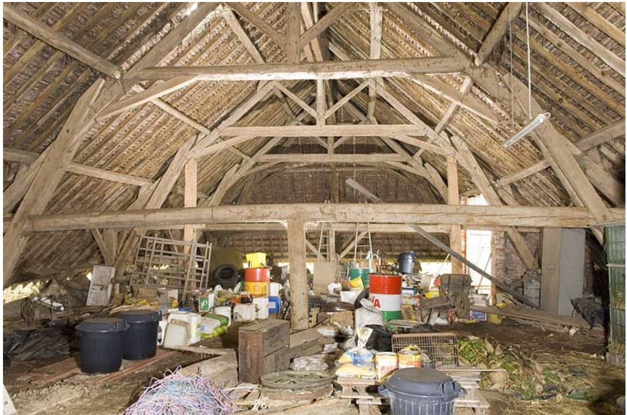
Séchoir. Partie sud de la charpente.
