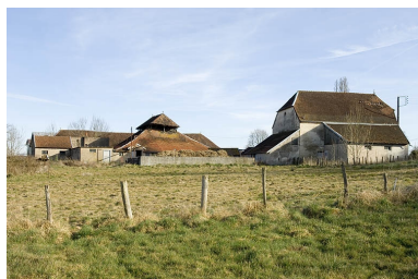
Vue rapprochée depuis le nord-ouest. Phot. Jérôme Mongreville IVR43_20097000129NUC2A
