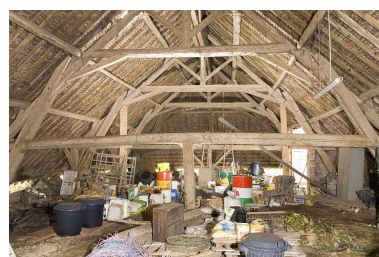
Séchoir. Partie sud de la charpente.
