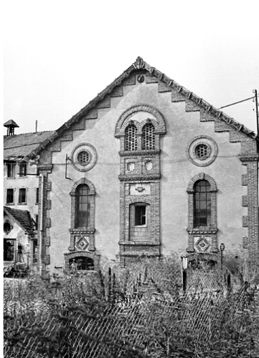
Mur-pignon de la briqueterie (?) vers 1980. Phot. Jérôme Mongreville IVR43_20019000108X
