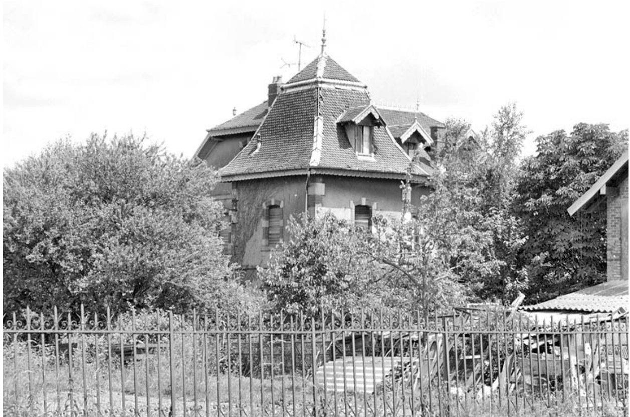
Toitures du logement patronal.
