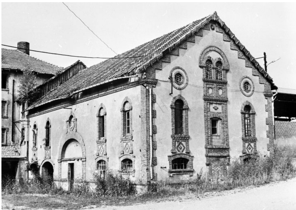
Briqueterie (?) vue de trois quarts vers 1980.
