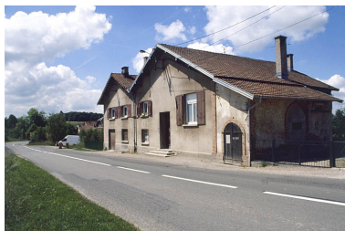
Chaudière et salle des machines depuis le nord. Phot. Yves Sancey IVR43_20009000403ZA
