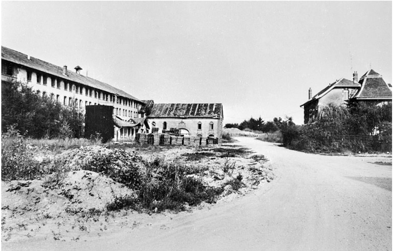
Vue d'ensemble depuis l'ouest vers 1980.
