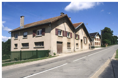
Chaudière et salle des machines, et logement. Phot. Yves Sancey IVR43_20009000401ZA
