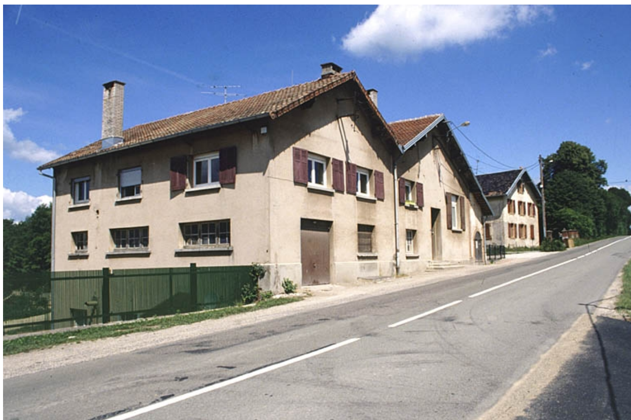
Chaufferie et salle des machines, et logement.
