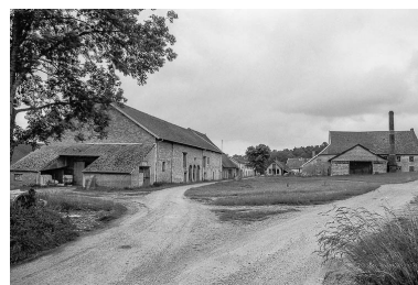
Verrerie de la Vieille- Loye : la cour en 1980 Phot. Bernard Lardière IVR43_19803900294Z
