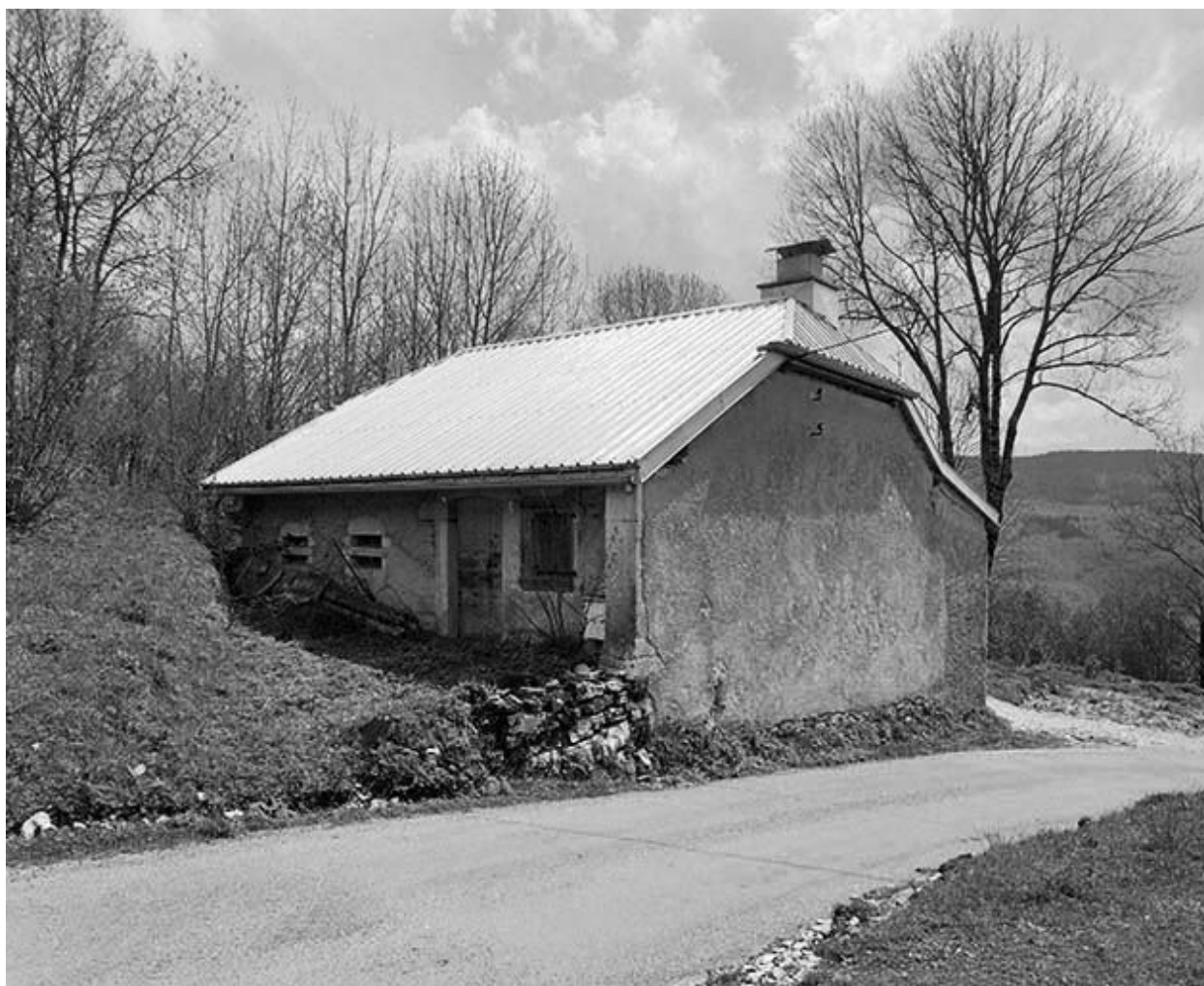
Fromagerie située au lieudit Les Mouillés.
