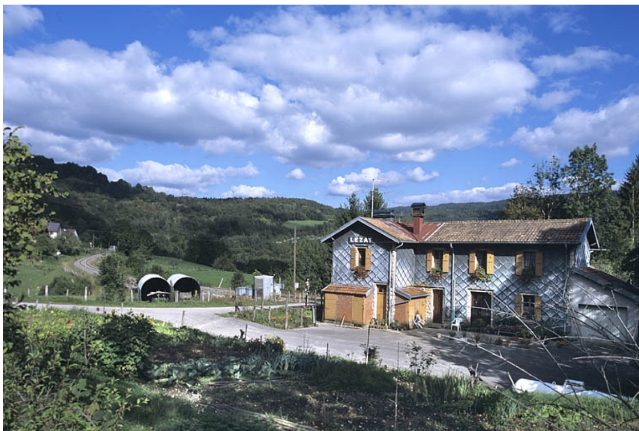
Gare dite station de Lézat (voie ferrée Andelot - La Cluse).
