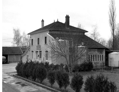
Vue rapprochée depuis la rue. Phot. Yves Sancey IVR43_19973900320X
