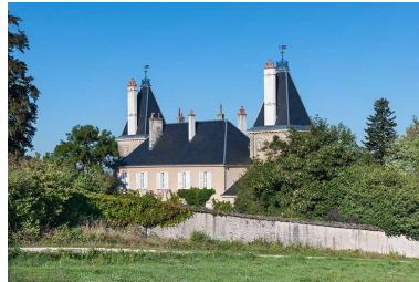
Vue générale sud-est Phot. Jérôme Mongreville IVR43_20137000158NUCA
