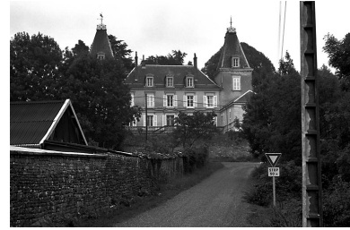
Façade antérieure. Phot. Dominique Dominguez IVR43_19807000510X
