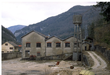
Cour, atelier de fabrication et château d'eau.
