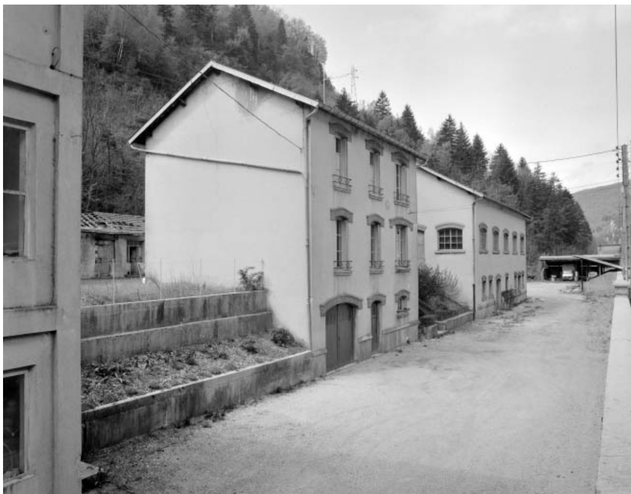
Bureau, logement et atelier de fabrication.
