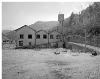
Cour, atelier de fabrication et château d'eau.
