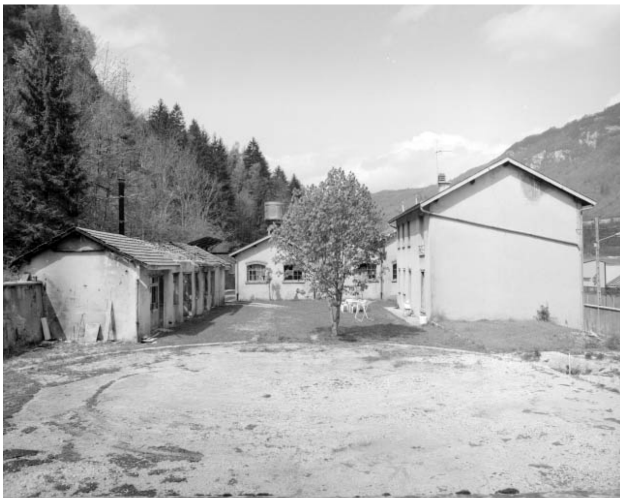
Logement et atelier de réparation. Au premier plan, emplacement du gazomètre.
