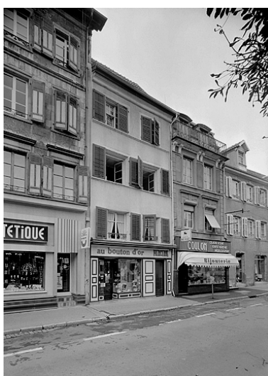
Maison 27, place Denfert- Rochereau. Milieu 16e siècle. Phot. Jérôme Mongreville IVR43_19872500964V
