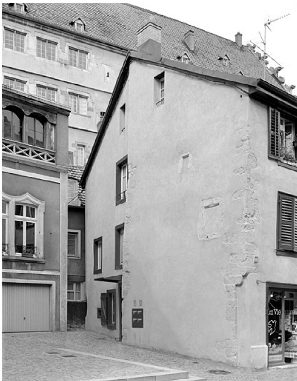
Maison 47, rue de Belfort. 16e siècle.
