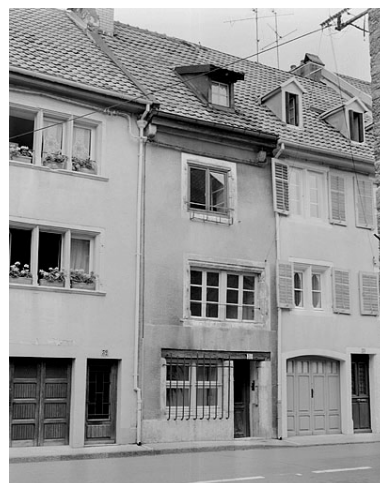
Maison 30, rue des Halles. 16e siècle. Phot. Jérôme Mongreville IVR43_19872500442X
