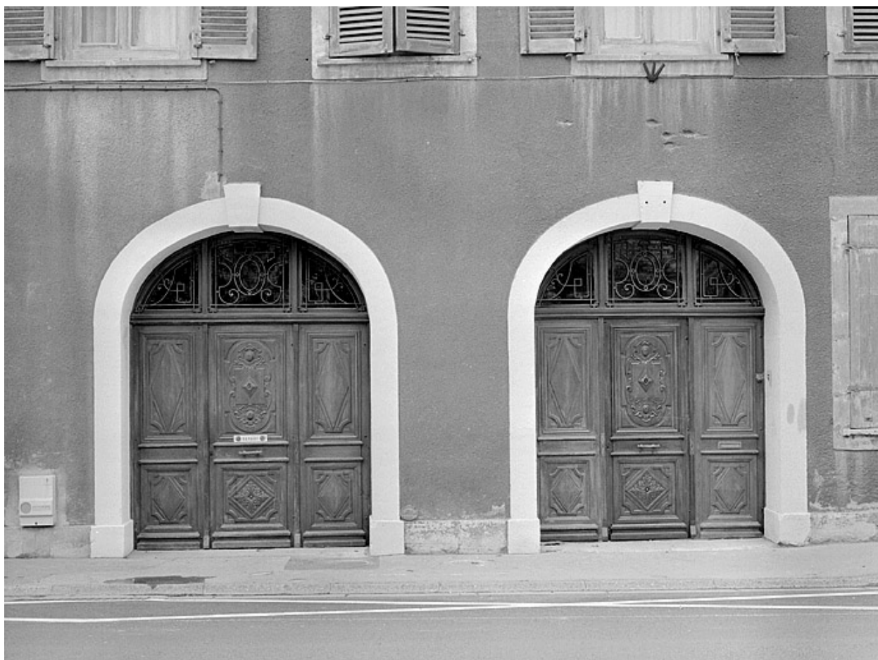
Maison 63, rue du Faubourg, Vers 1826.
