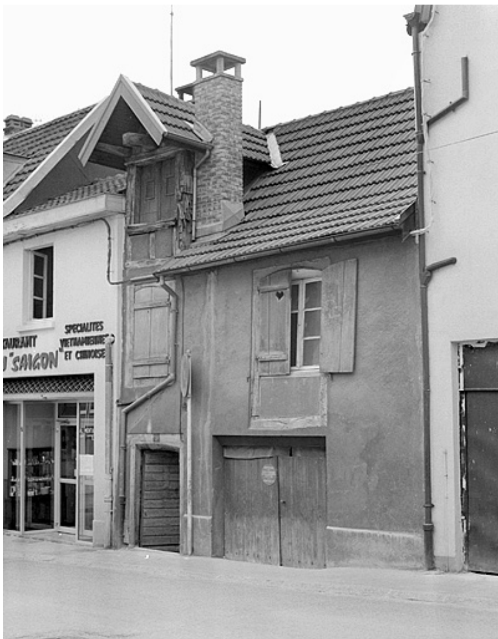
Maison 9, rue Saint-Georges. Porte la date 1770.
