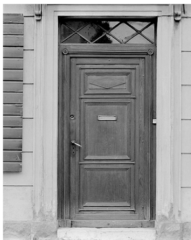
Maison 18, rue Viette. Porte. Vers 1840-1850. Phot. Jérôme Mongreville IVR43_19872500455X
