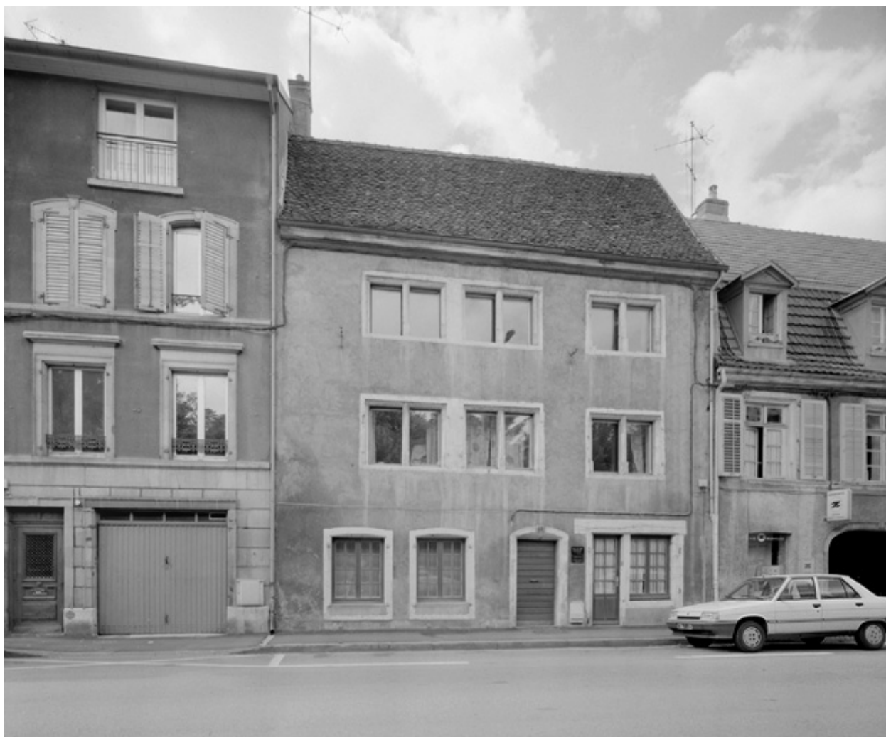
Maison 49, rue du Faubourg. Première moitié 17e siècle.
