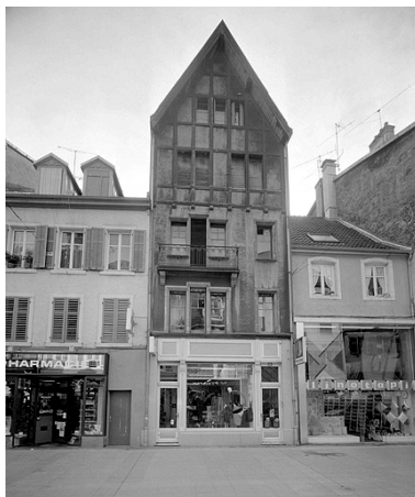
Immeuble 39, rue Cuvier. Début 20e siècle. Phot. Jérôme Mongreville IVR43_19872501074V
