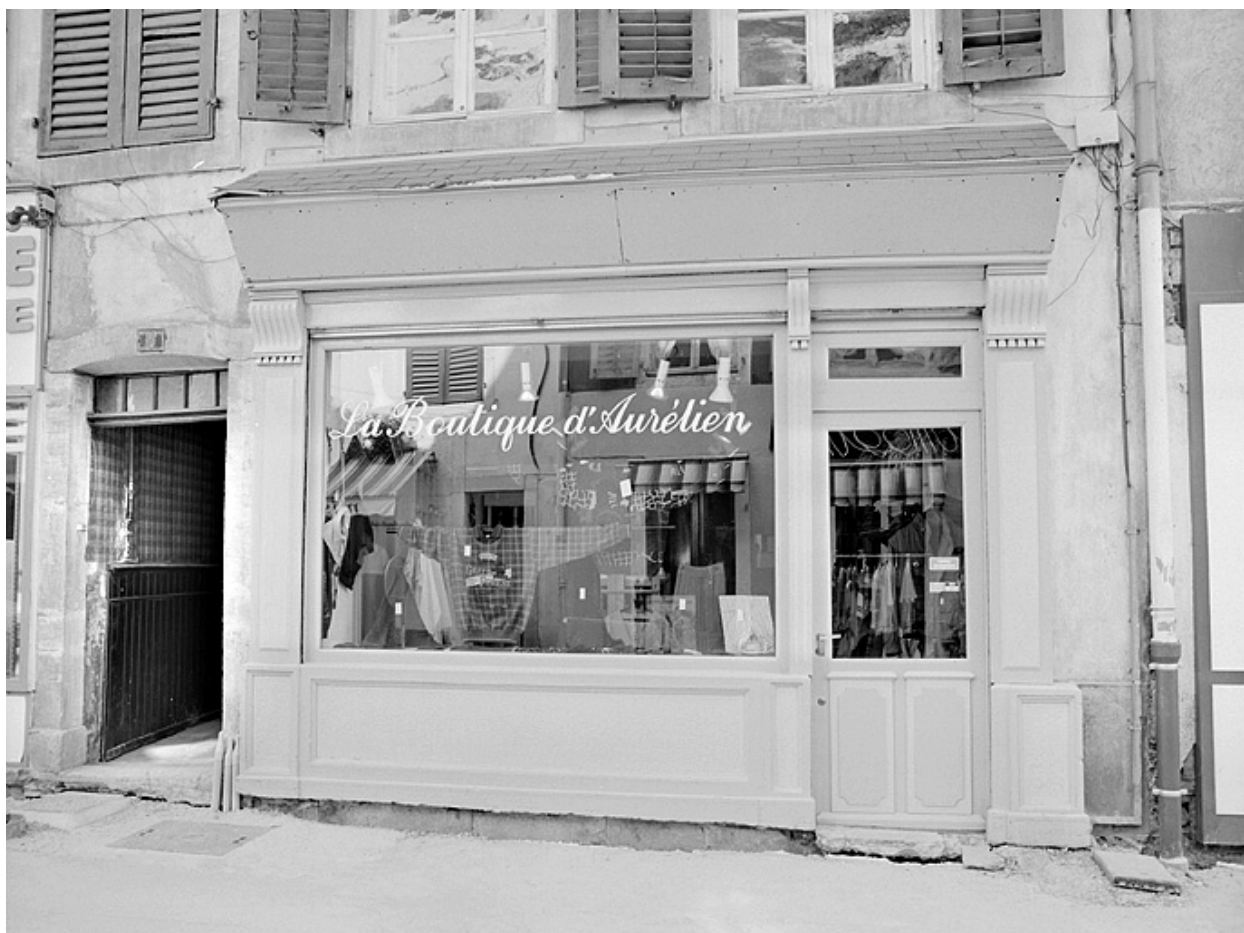
Maison 6, rue de Belfort. Devanture. Dernier quart 19e siècle.
