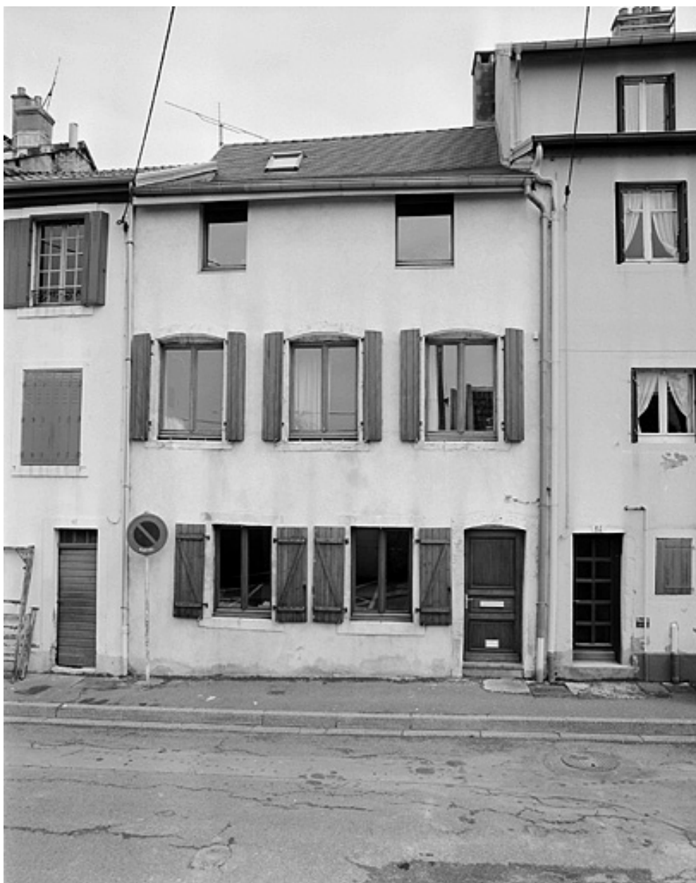
Maison 16, rue des Potiers. 18e siècle.
