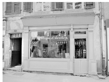
Maison 6, rue de Belfort. Devanture. Dernier quart 19e siècle. Phot. Jérôme Mongreville IVR43_19872500956X
