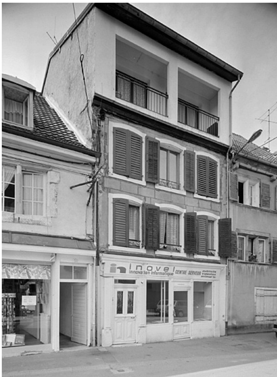
Maison 18, rue Diemer-Duperret. 18e siècle.
