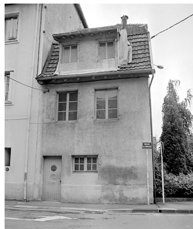
Maison 14, quai des Tanneurs. 19e siècle. Phot. Jérôme Mongreville IVR43_19872500453X
