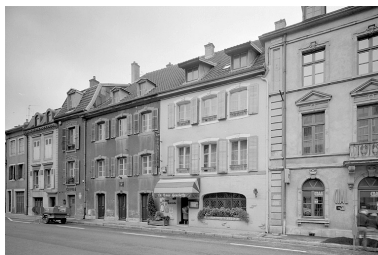
Maisons 57 et 59, rue du Faubourg. 18e siècle. Phot. Jérôme Mongreville IVR43_19872501249V
