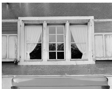
Maison 5, place Francisco-Ferrer. Fenêtre de gauche au premier étage. Première moitié 17e siècle. Phot. Jérôme Mongreville IVR43_19872500567X
