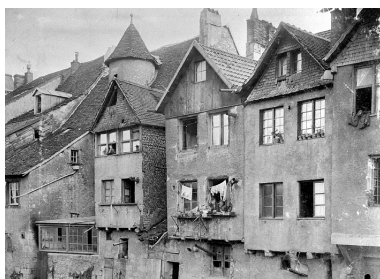
Maisons 22 à 33, rue des Halles. Façades sur la Lizaine, fin 19e siècle. Phot. Jérôme Mongreville IVR43_19872500149V
