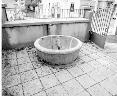
Fontaine (vestige de la brasserie). Phot. Yves Sancey IVR43_20033900244X
