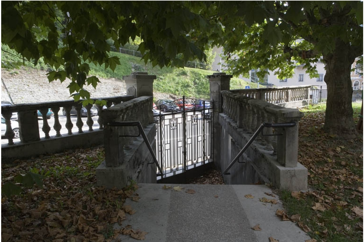
Escalier indépendant, côté jardin.
