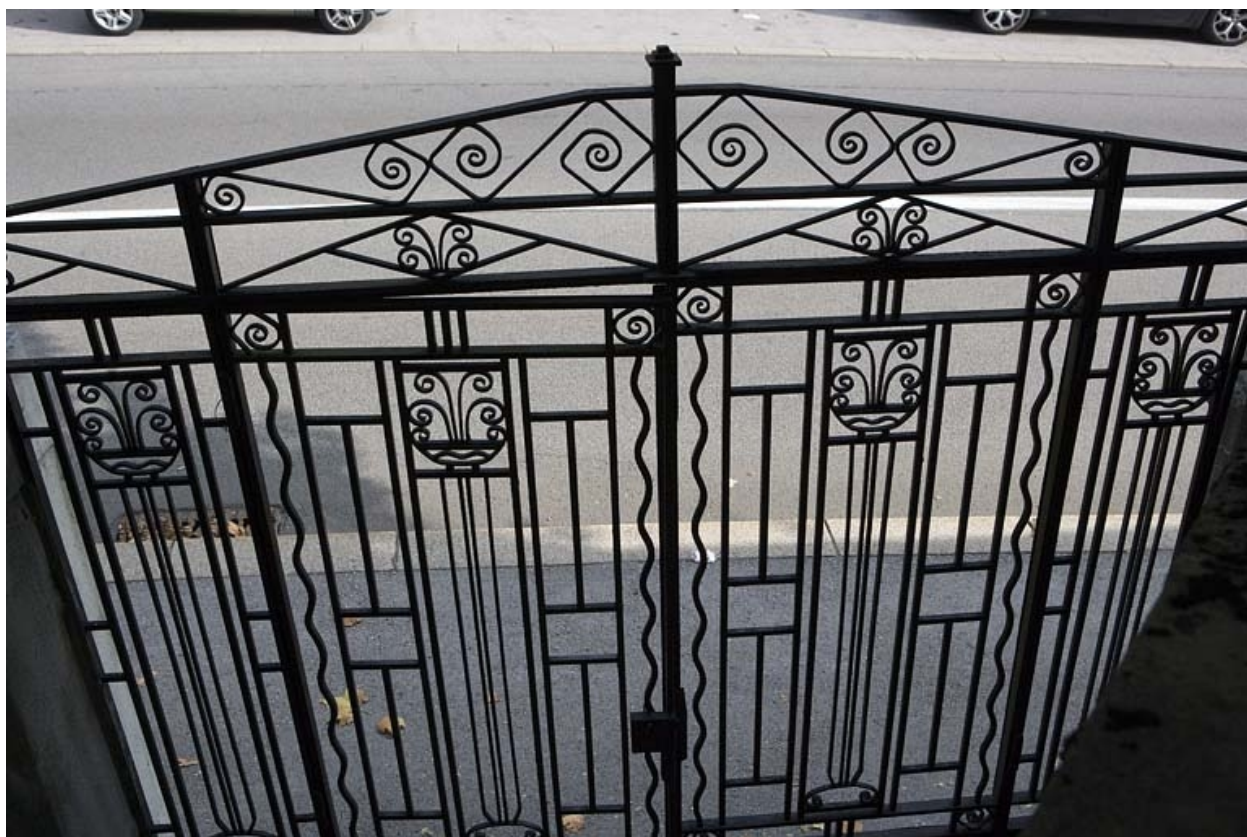
Détail de la grille de l'escalier indépendant.
