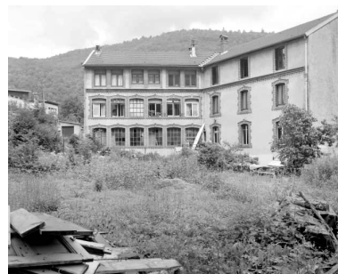
Façades postérieures. Phot. Jérôme Mongreville IVR43_19923900512X
