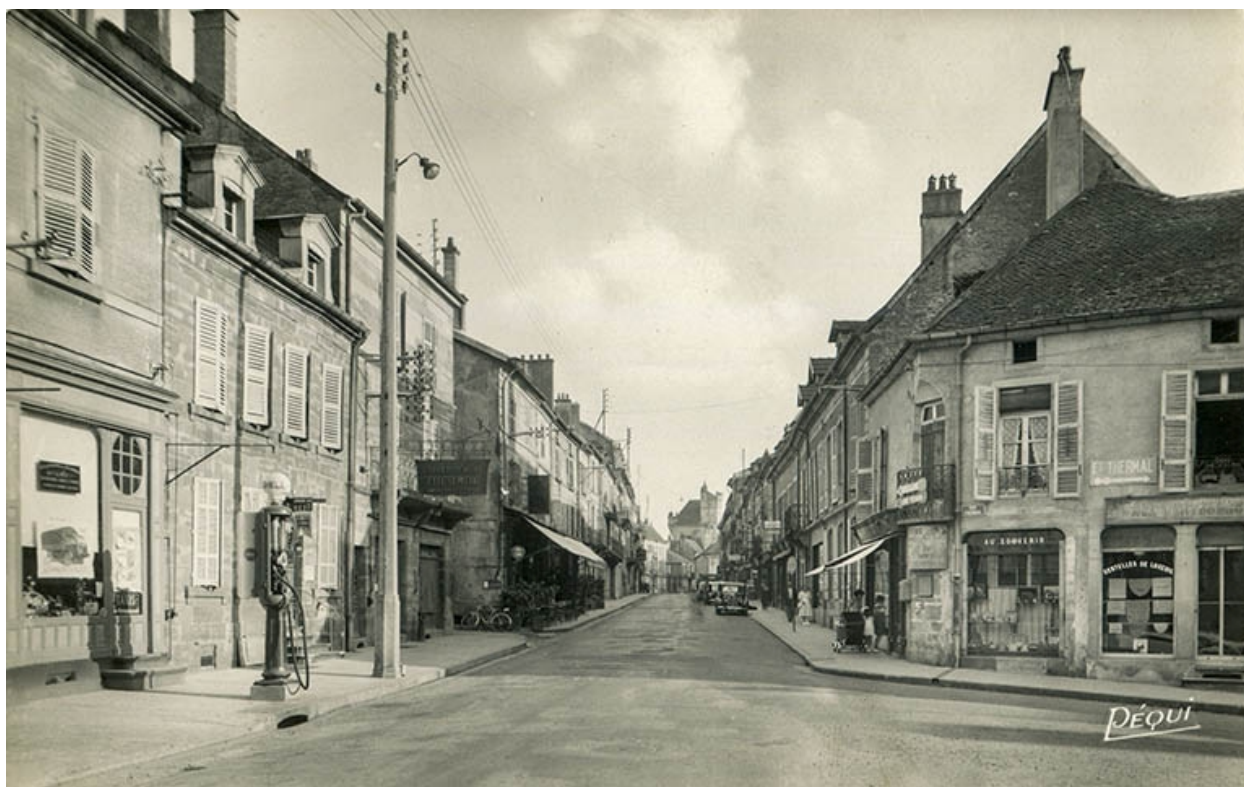
Vue de la rue Carnot.
