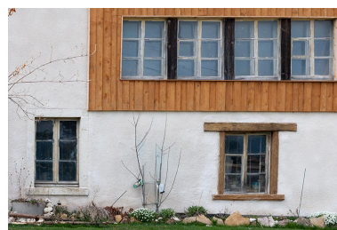
Fenêtres multiples de l'atelier. Phot. Jérôme Mongreville IVR43_20142500187NUC4A
