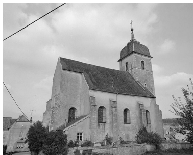
Face latérale gauche. Phot. Yves Sancey IVR43_19757000051X
