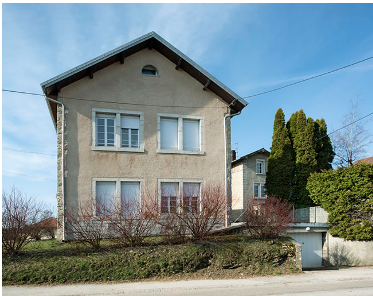
Atelier de fabrication : façade nord.
