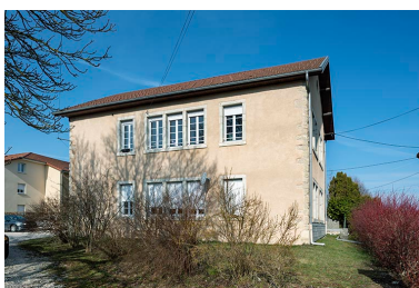
Atelier de fabrication : façade est.
