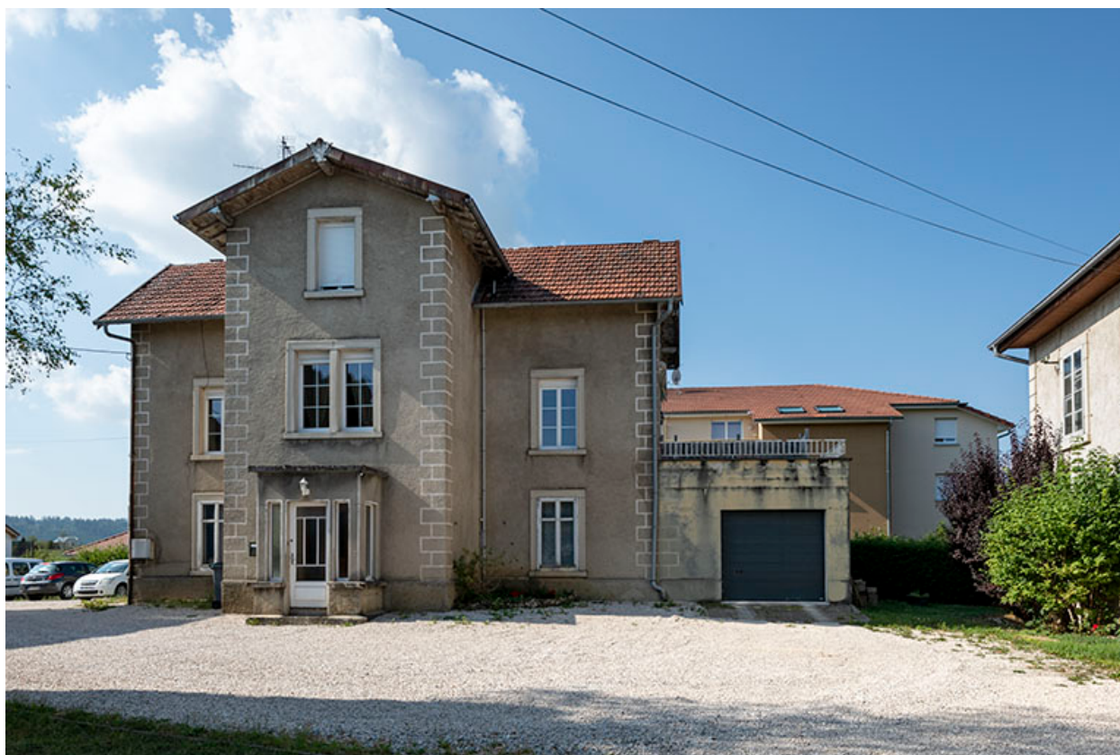
Logement de contremaître.
