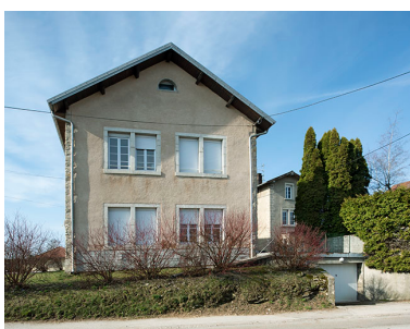
Atelier de fabrication : façade nord.
