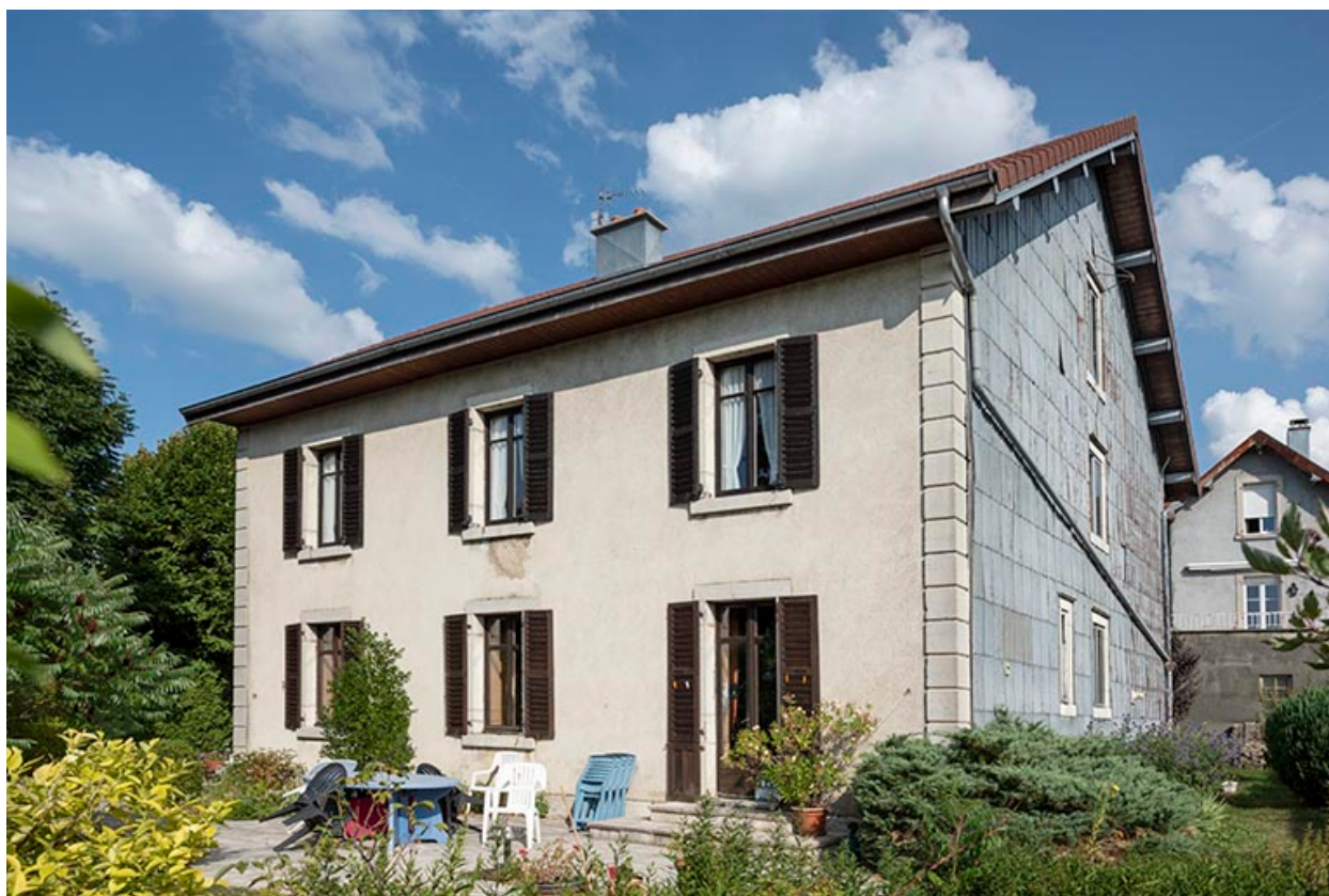
Maison : façade postérieure, de trois quarts droite.
