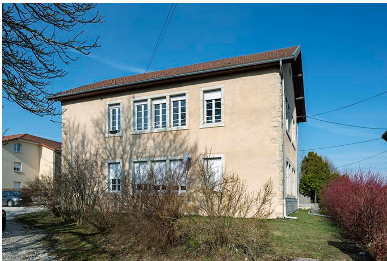
Atelier de fabrication : façade est.
