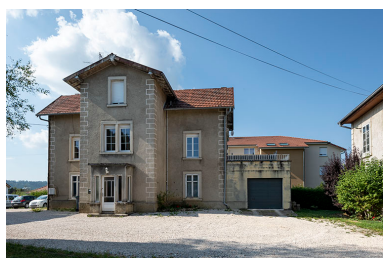
Logement de contremaître.
