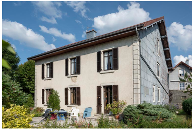
Maison : façade postérieure, de trois quarts droite.
