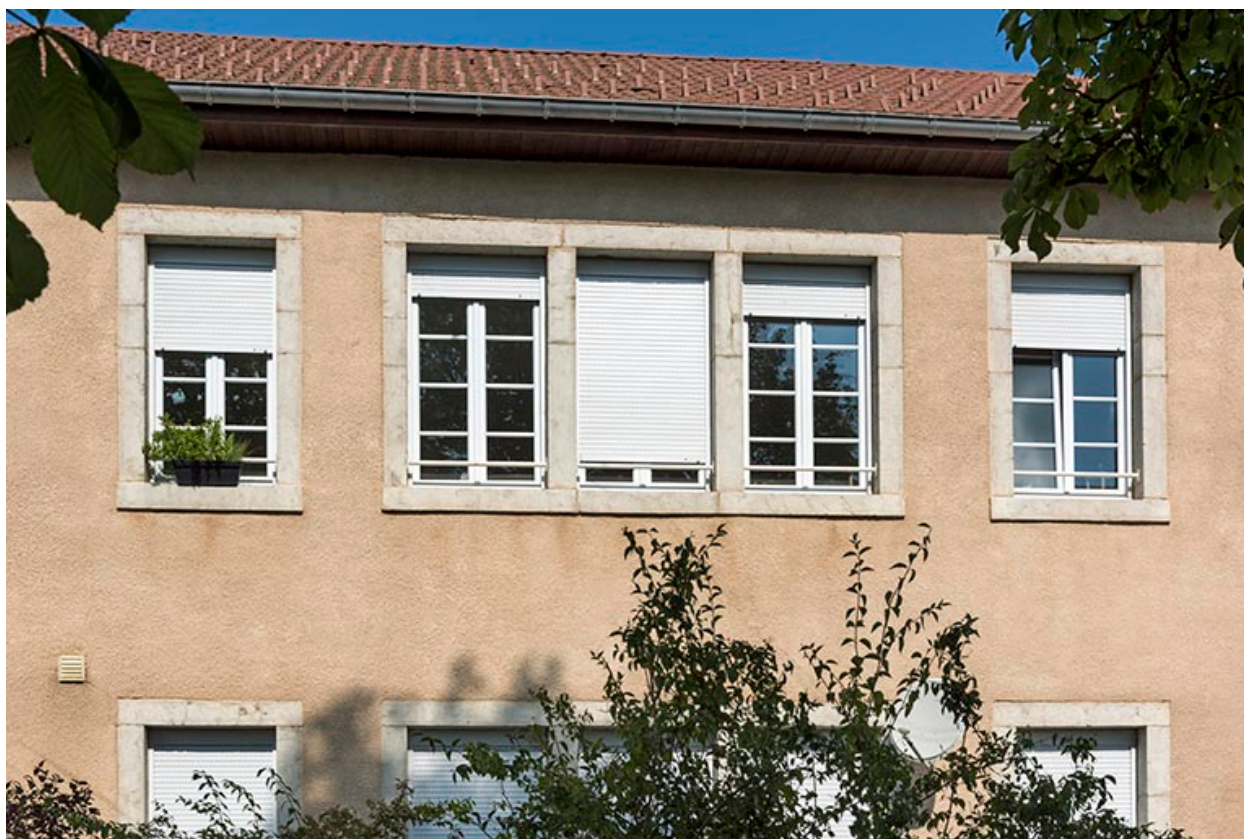
Atelier de fabrication, façade est : fenêtres multiples.
