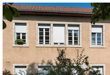
Atelier de fabrication, façade est : fenêtres multiples.
