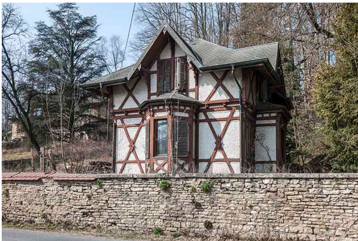
Façade sud de la conciergerie.
