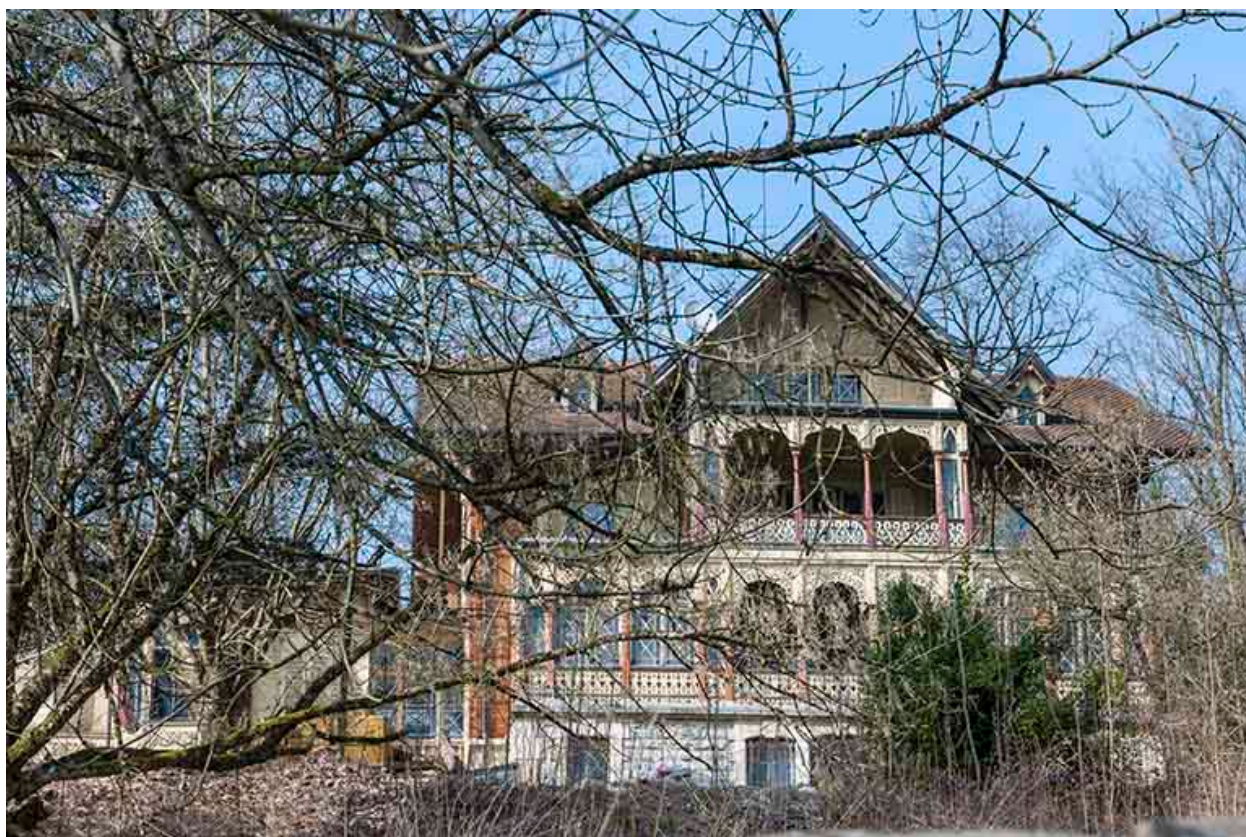
Façade sud du logement patronal.
