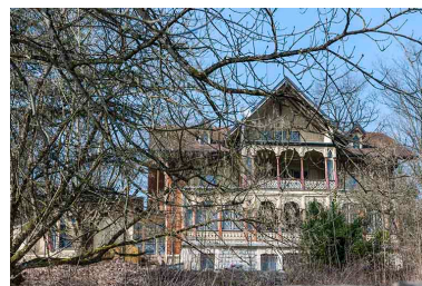
Façade sud du logement patrimonial. Phot. Jérôme Mongreville
