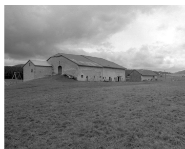
Façade postérieure des deux fermes mitoyennes. Phot. Jérôme Mongreville IVR43_19943900903X
