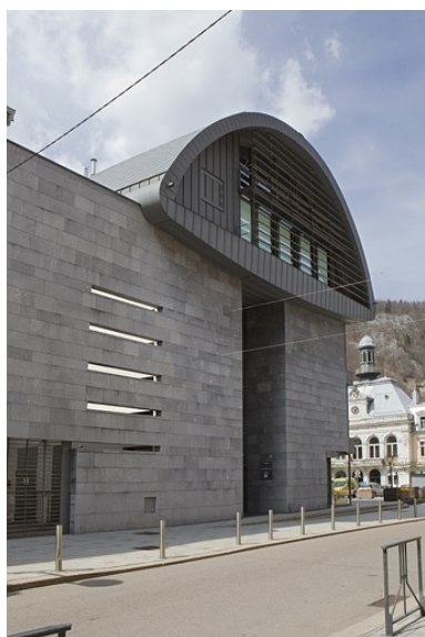
Façade latérale gauche. Phot. Yves Sancey IVR43_20103900161NUC2A
