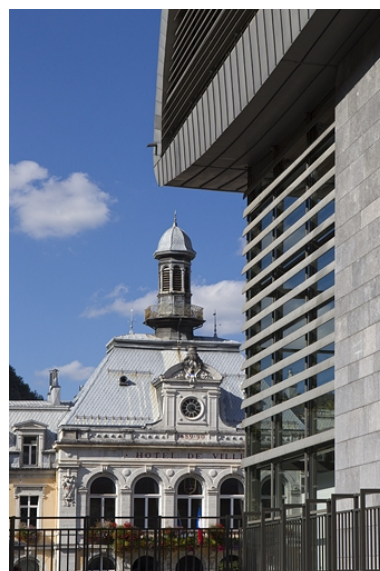
Façade latérale droite : détail. Phot. Yves Sancey IVR43_20103900597NUC2A
