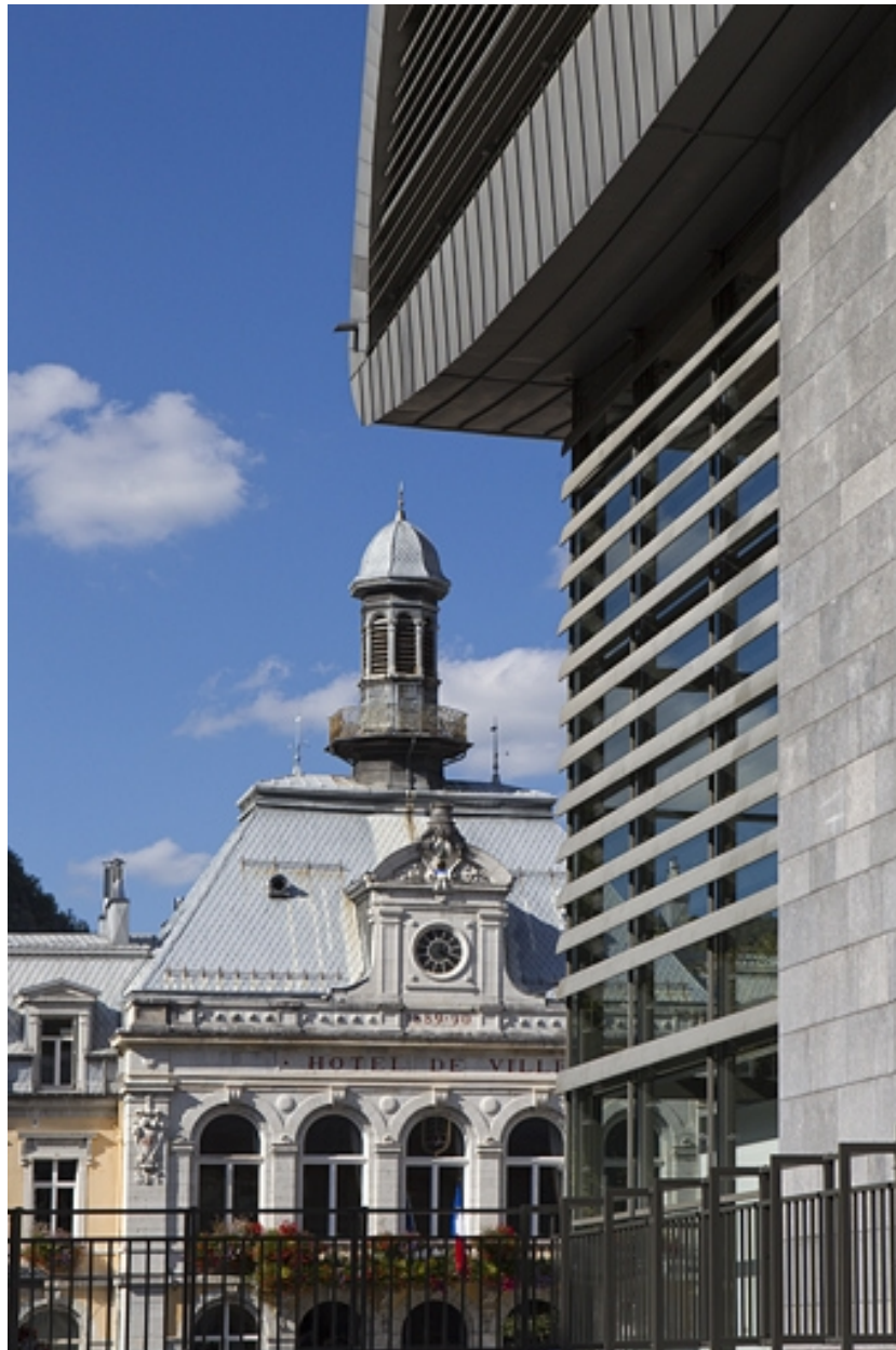
Façade latérale droite : détail.
