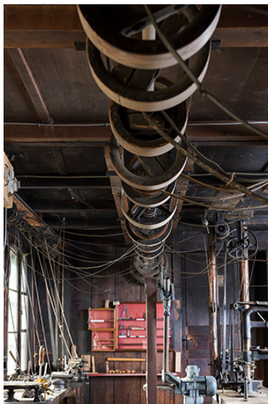
Ligne de transmission principale, entre les deux grands établis. Phot. Sonia Dourlot IVR43_20172500042NUC4A
