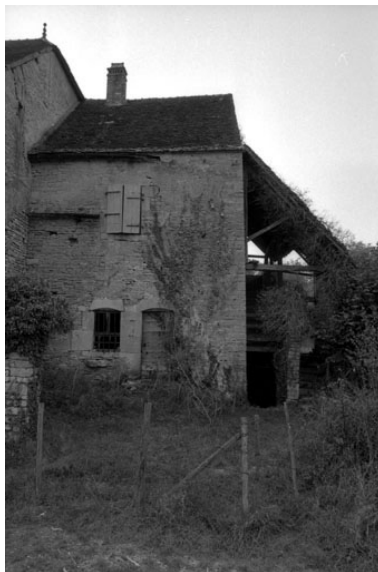
Partie habitation. Phot. Bernard Lardière IVR43_19797000048Z
